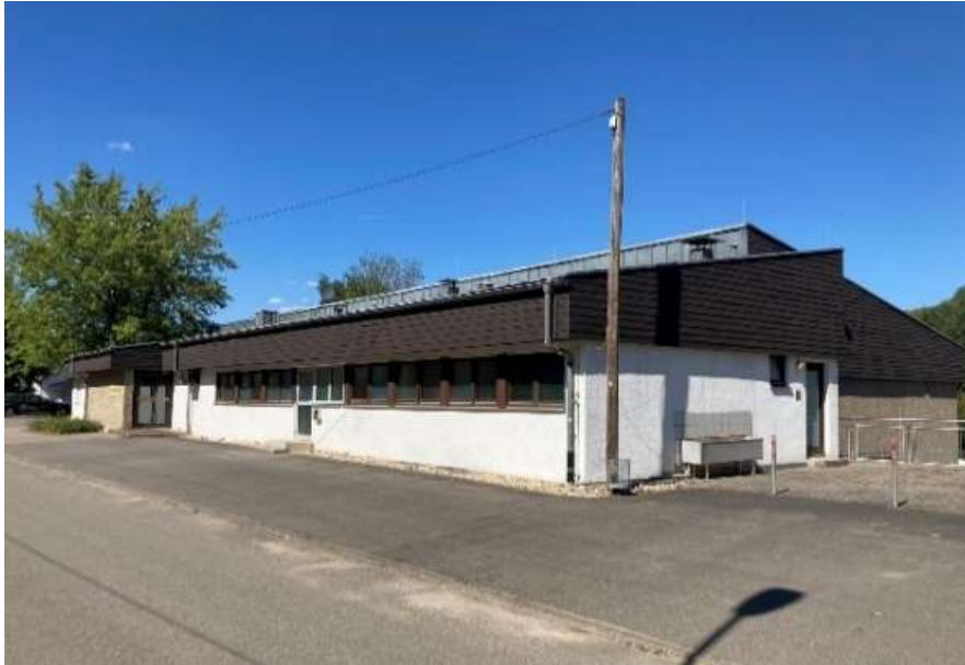
Nordseite (rechts die Zufahrtsstraße und links die asphaltierte Hoffläche)
