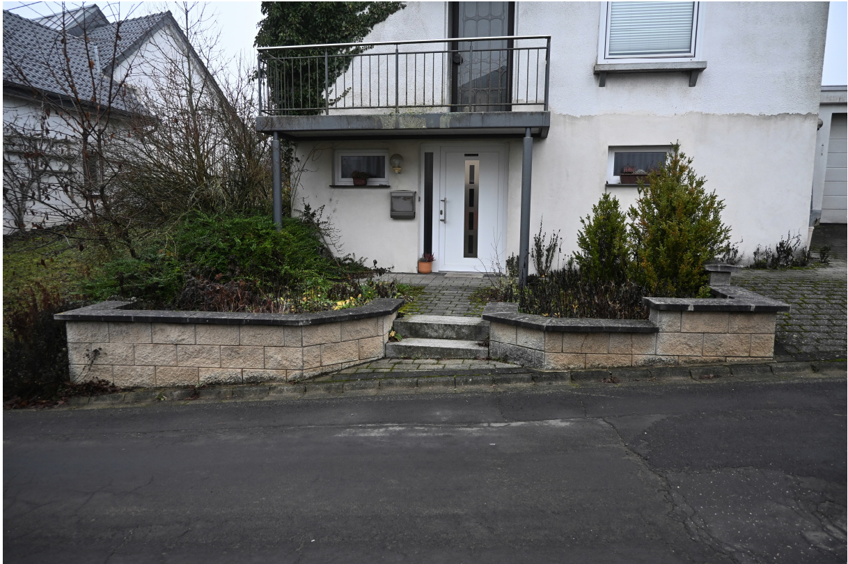
Los 1, Anlage 1, Mauer in Heckhalenfelder Str. 10, Abbruch und Neubau nach Verschiebung nach hinten
