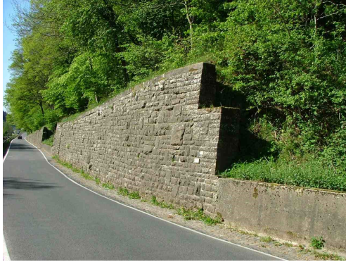
Bild 2: Seitenansicht - Richtung: St. Thomas
