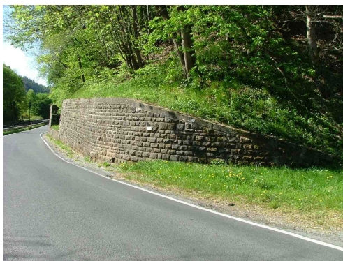
Bild 1: Seitenansicht Teilbauwerk A
