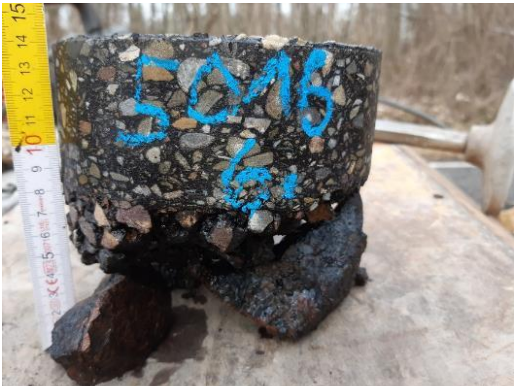
Bild 15: Detailaufnahme, Bohrkern aus BK 6
