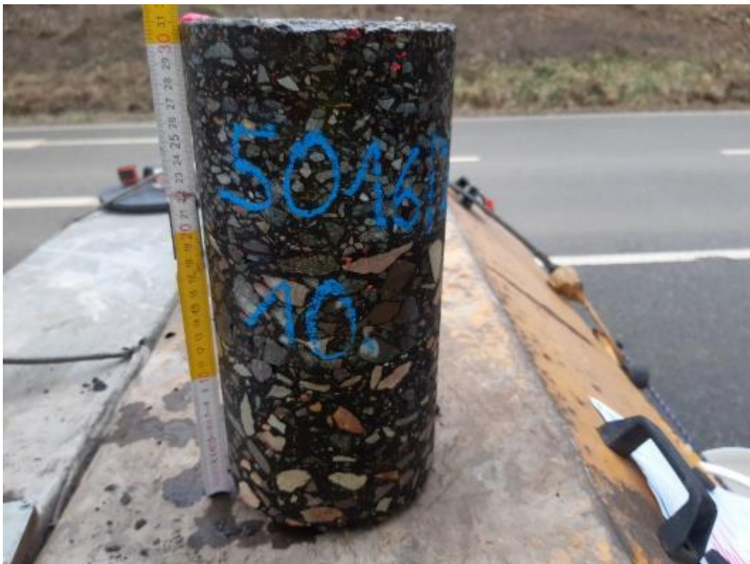
Bild 27: Detailaufnahme, Bohrkern aus BK 10
