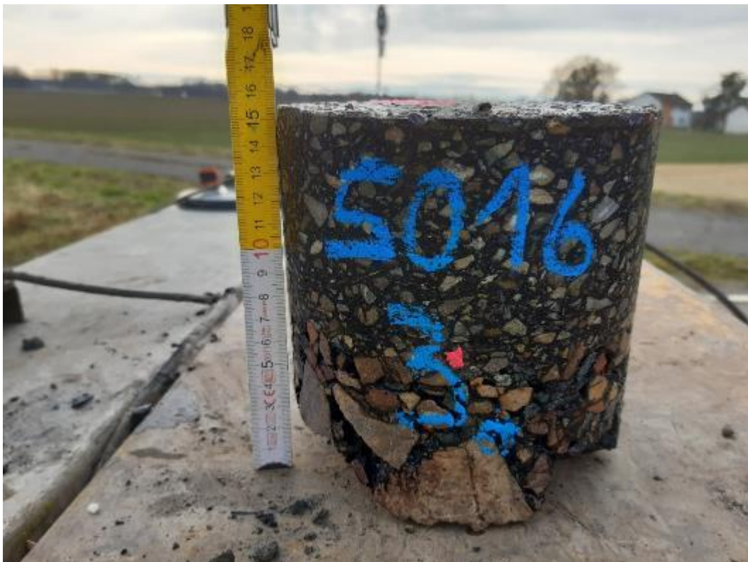
Bild 6: Detailaufnahme, Bohrkern aus BK 3
