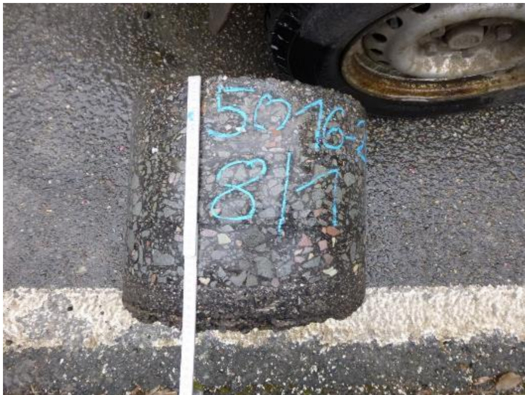
Bild 19: Detailaufnahme, Bohrkern aus EK 8
