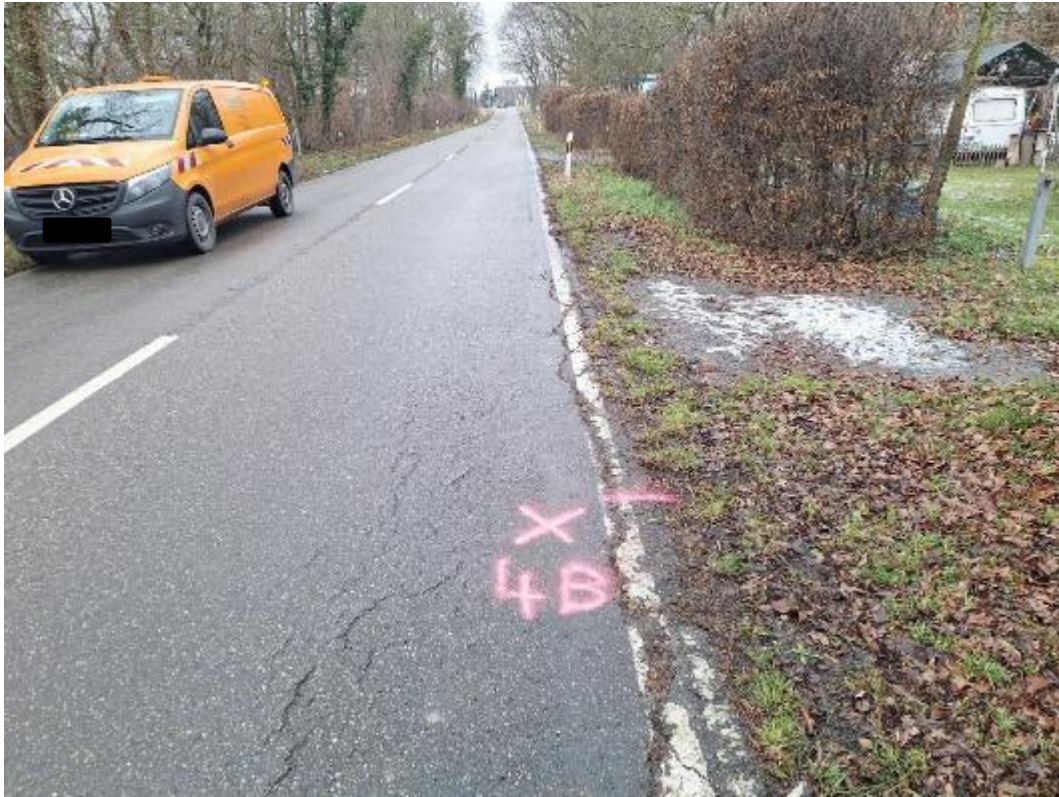
Bild 10: Messstellenbereich BK 4B
