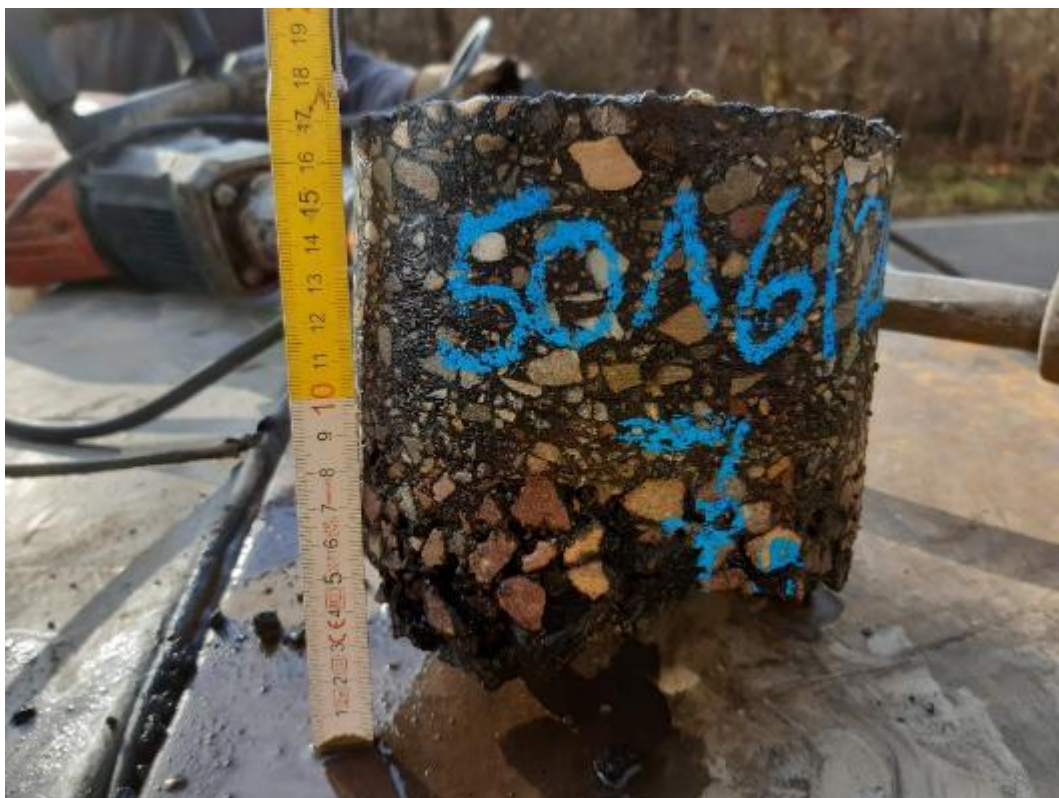
Bild 17: Detailaufnahme, Bohrkern aus BK 7
