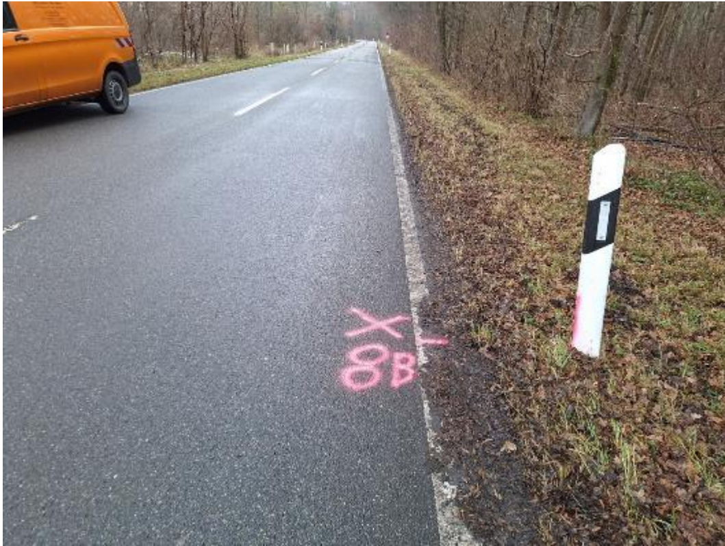
Bild 22: Messstellenbereich BK 8B
