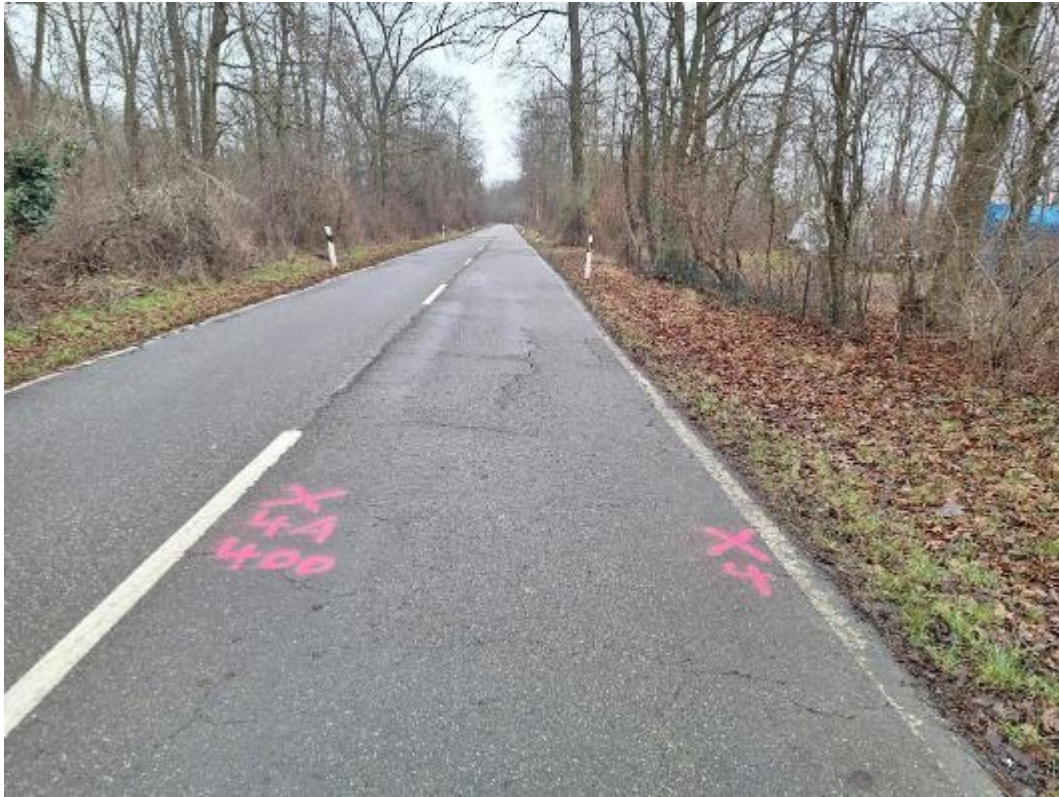
Bild 7: Messstellenbereiche BK 4 und EK 4A
