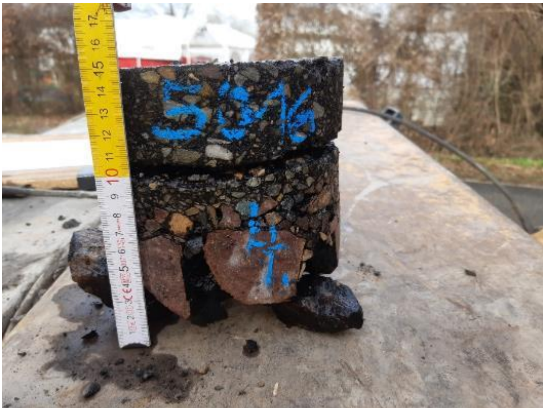
Bild 8: Detailaufnahme, Bohrkern aus BK 4
