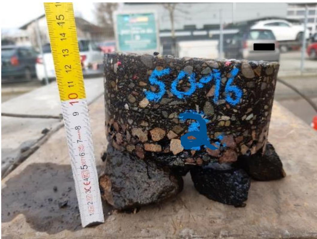
Bild 4: Detailaufnahme, Bohrkern aus BK 2
