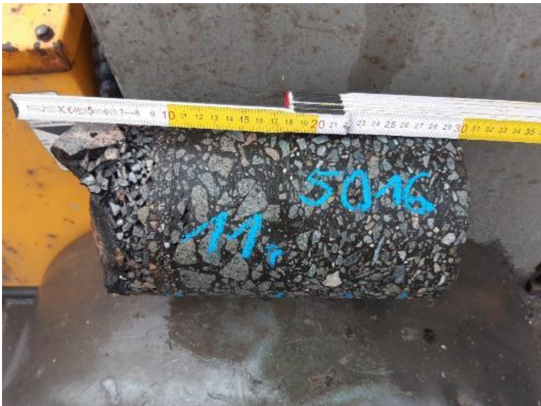
Bild 29: Detailaufnahme, Bohrkern aus BK 11
