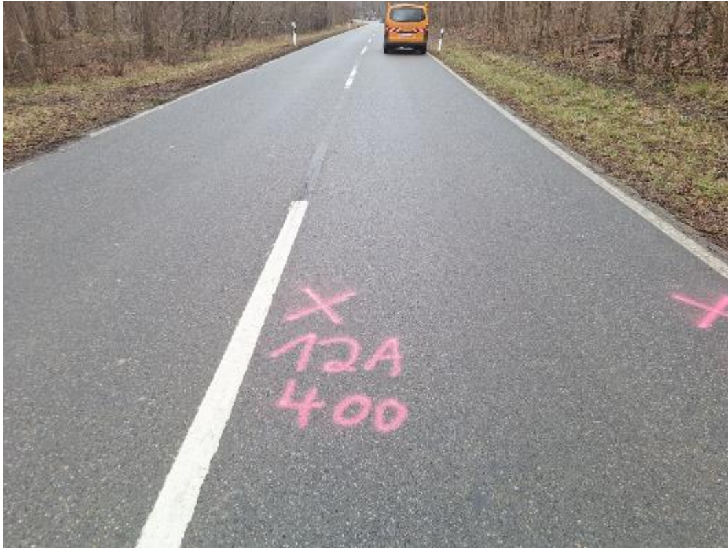
Bild 32: Messstellenbereich EK 12A
