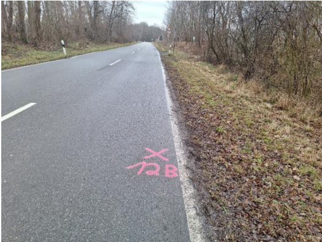
Bild 34: Messstellenbereich BK 12B
