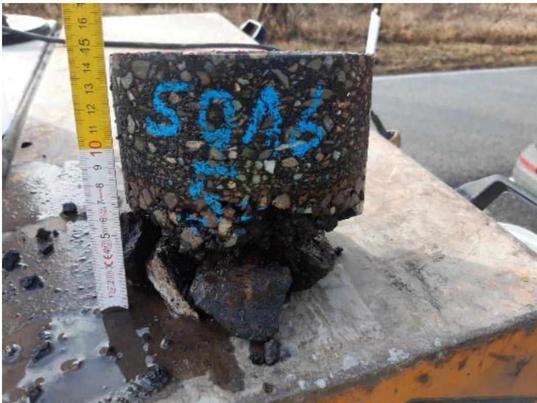
Bild 13: Detailaufnahme, Bohrkern aus BK 5
