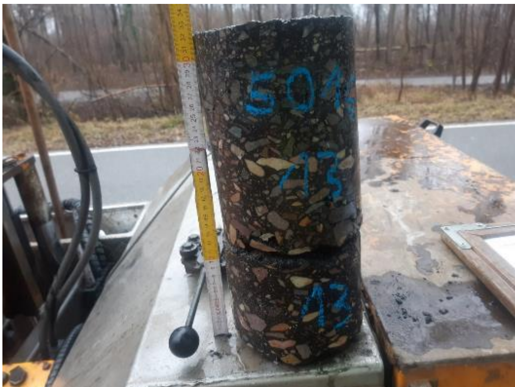
Bild 37: Detailaufnahme, Bohrkern aus BK 13
