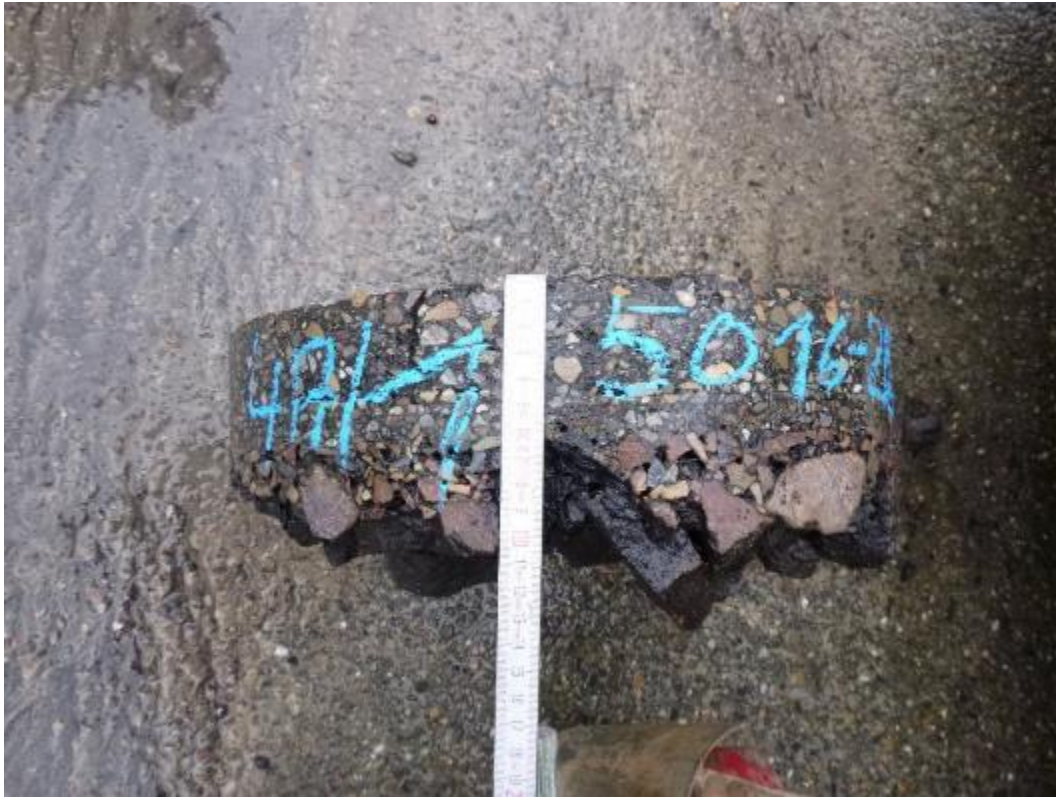
Bild 9: Detailaufnahme, Bohrkern aus EK 4A
