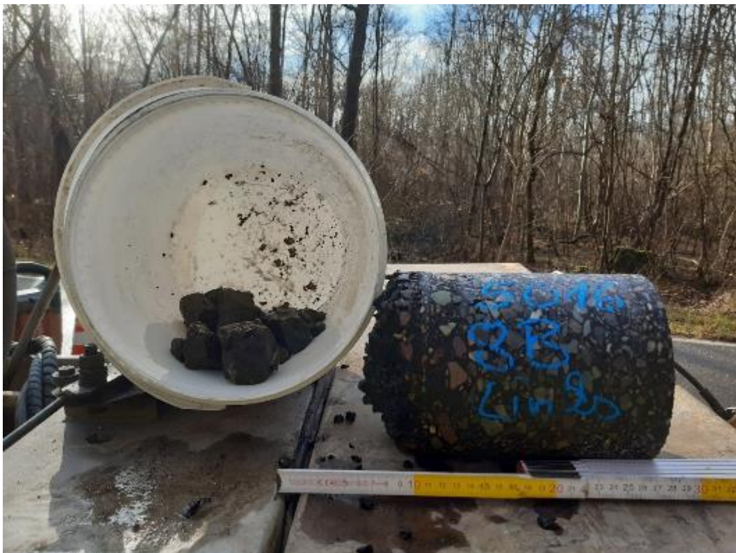
Bild 23: Detailaufnahme, Bohrkern aus BK 8B
