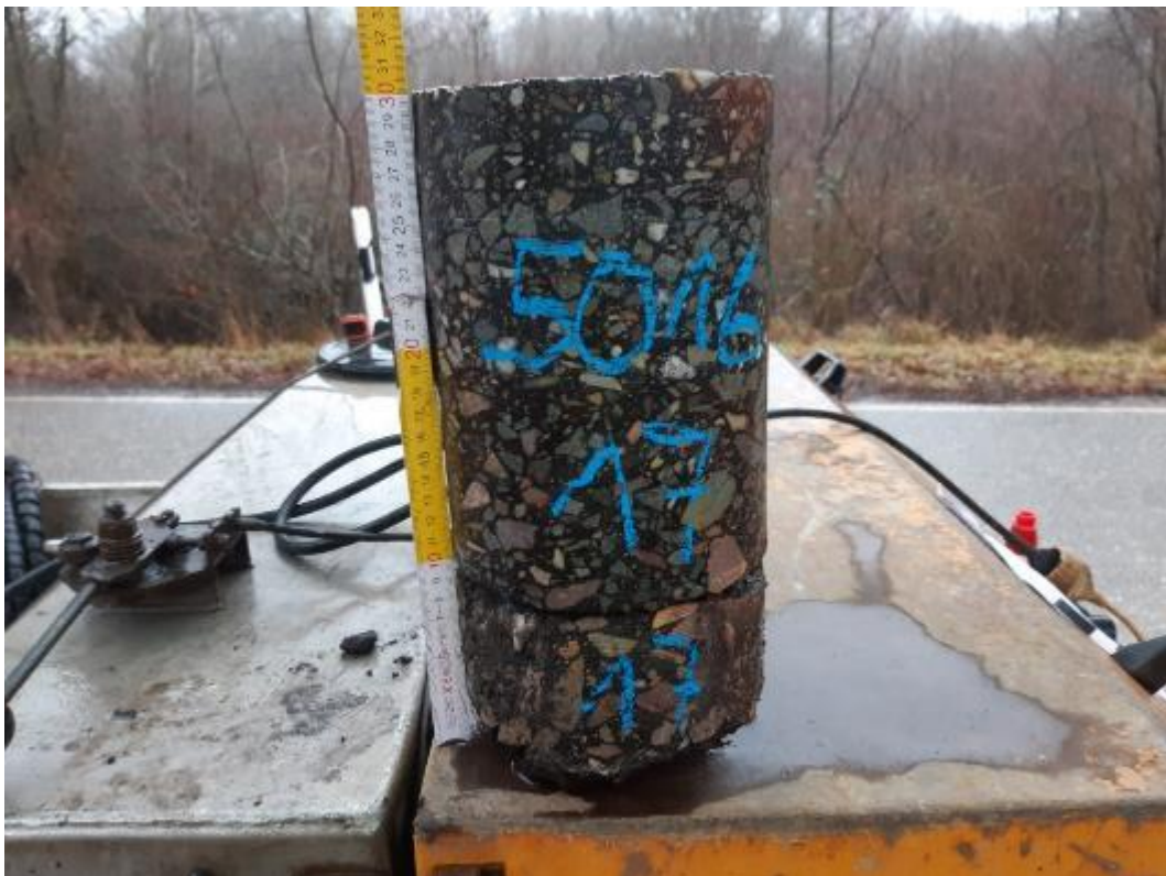
Bild 47: Detailaufnahme, Bohrkern aus BK 17
