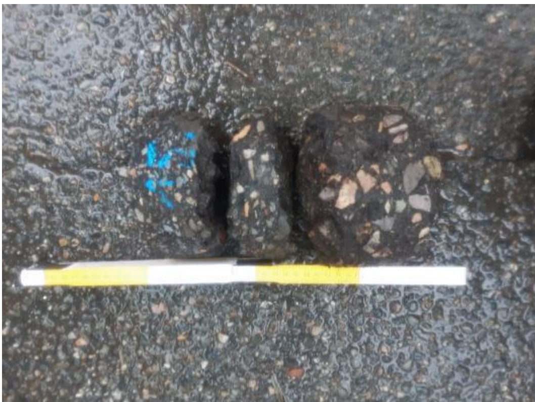
Bild 41: Detailaufnahme, Bohrkern aus BK 15
