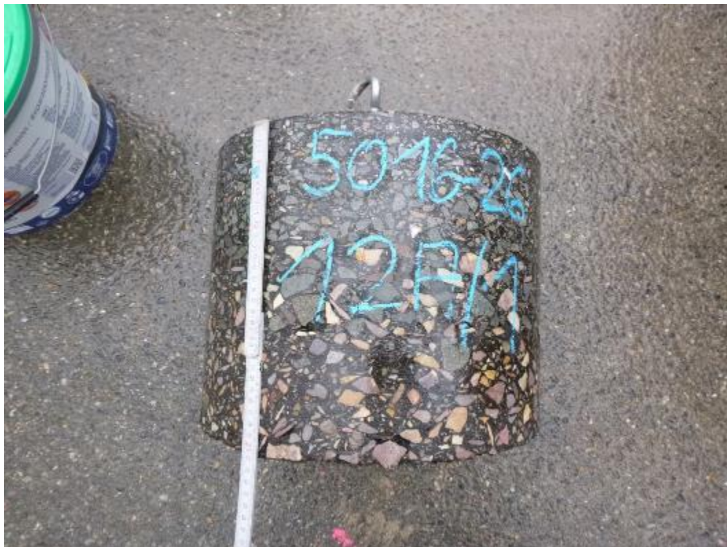
Bild 33: Detailaufnahme, Bohrkern aus EK 12A
