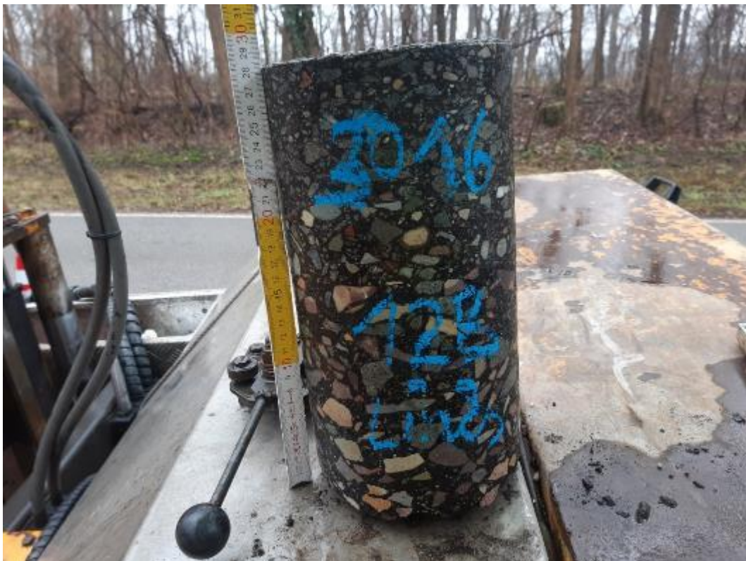
Bild 35: Detailaufnahme, Bohrkern aus BK 12B
