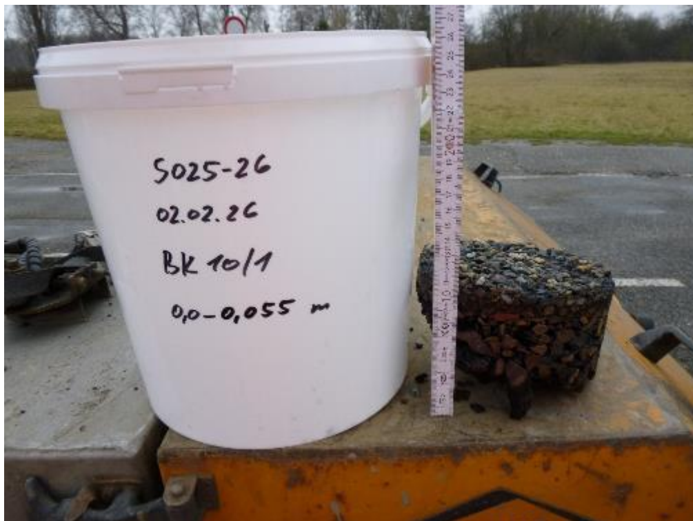
Bild 20: Detailaufnahme, Bohrkern aus BK 10
