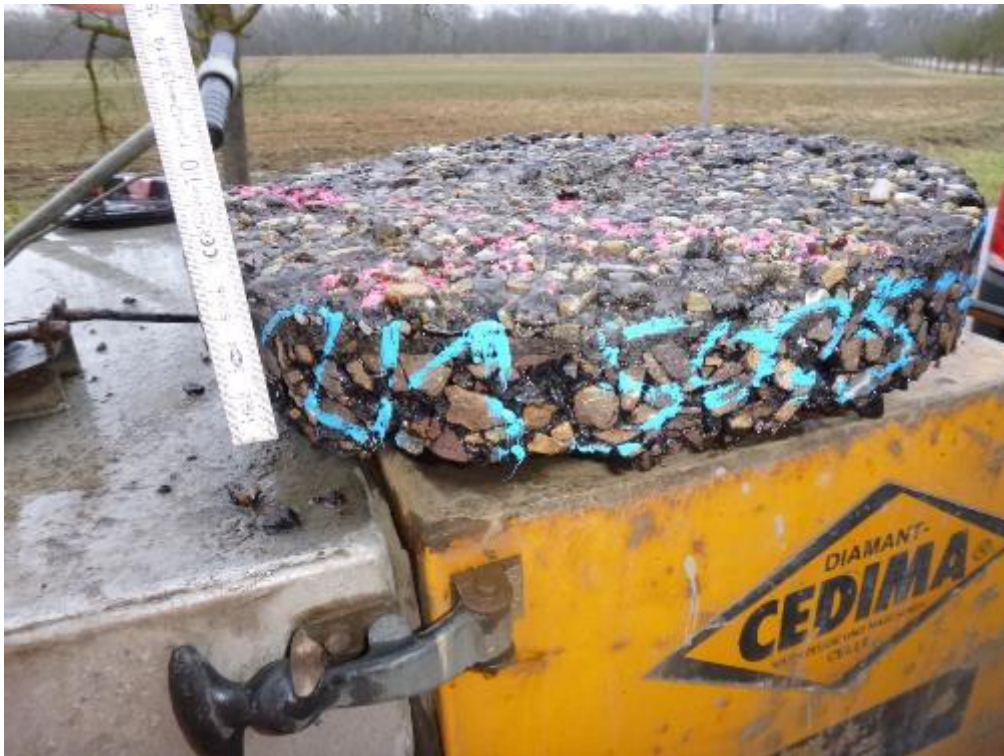
Bild 4: Detailaufnahme, Bohrkern aus EK 2
