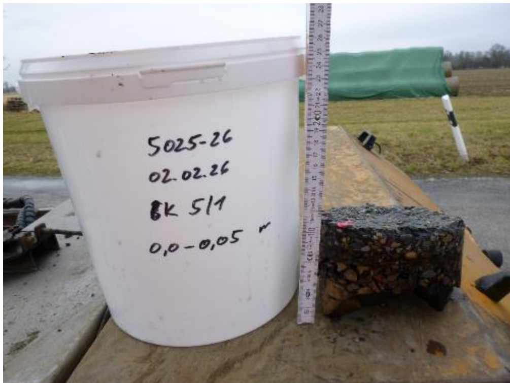
Bild 10: Detailaufnahme, Bohrkern aus BK 5
