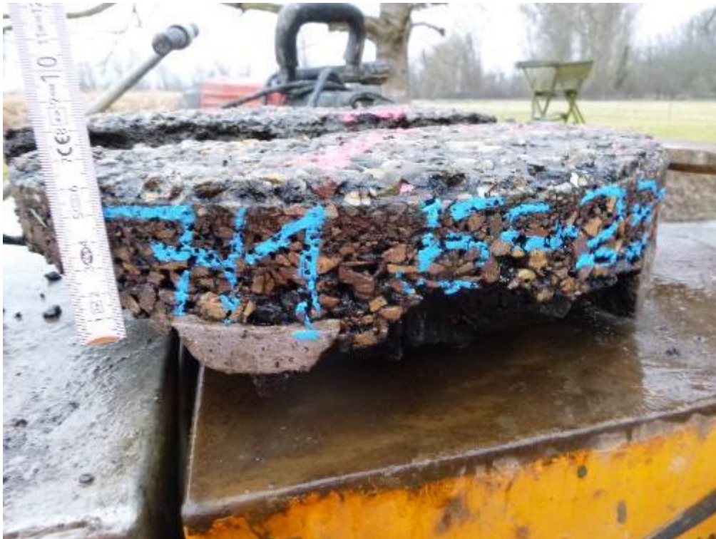
Bild 14: Detailaufnahme, Bohrkern aus EK 7
