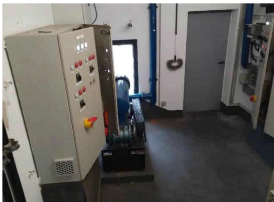
Steuerschranke Anlagetechnik
