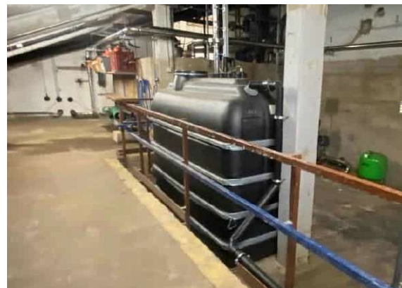
Vorlagebehälter (Hydranten/Beregnung)
