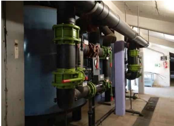
Filterbehälter mit Handklappen
