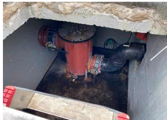
Haar-/Fasern Fänger / Siebkammer 50m Becken
