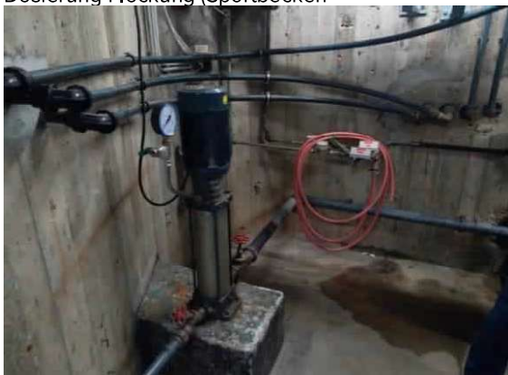
Treibwasserpumpe (Sportbecken)
