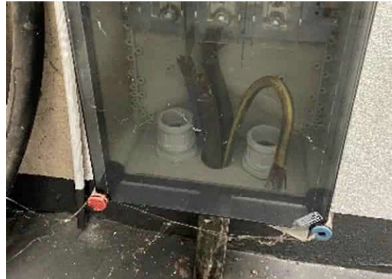
Abgangskabel, abgeklemmt
