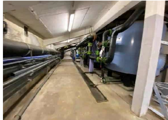
Filterbehälter mit Handklappen
