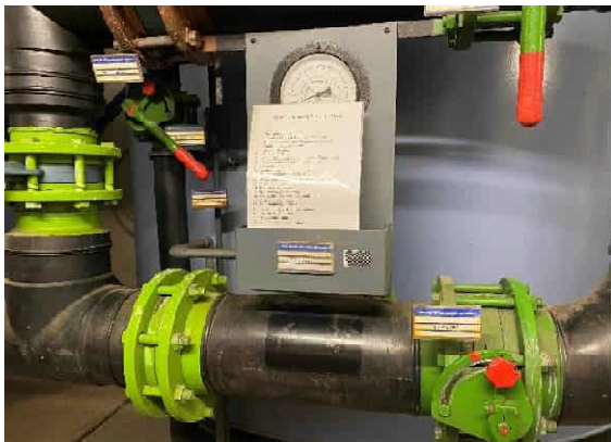
Filterbehälter mit Handklappen
