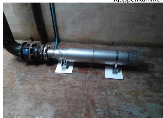
UW-Pumpe im SW Behälter
