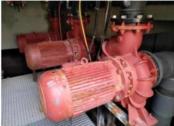
Saugpumpen der neuen 3 Becken
