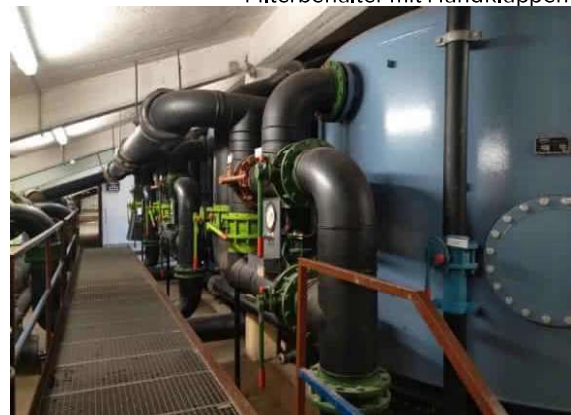
Filterbehälter mit Handklappen
