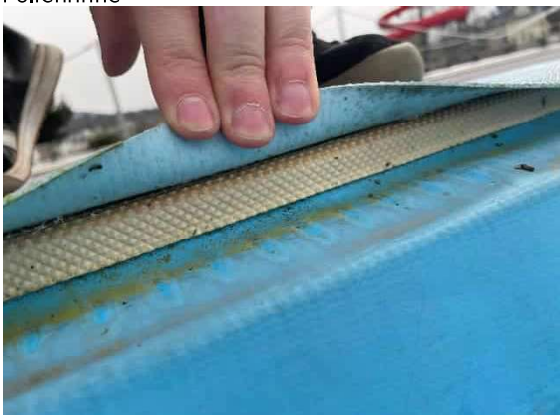
Folienanschluss Schwallwasserrinne
