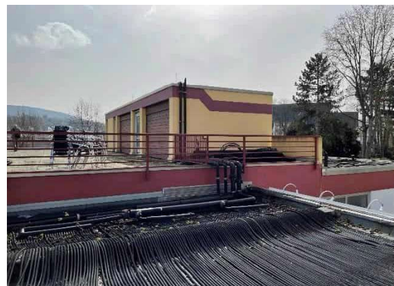
Absorberanlage Eingangsbereich
