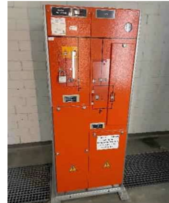
SF6 MS-Schaltanlage 20/0,4 kV
