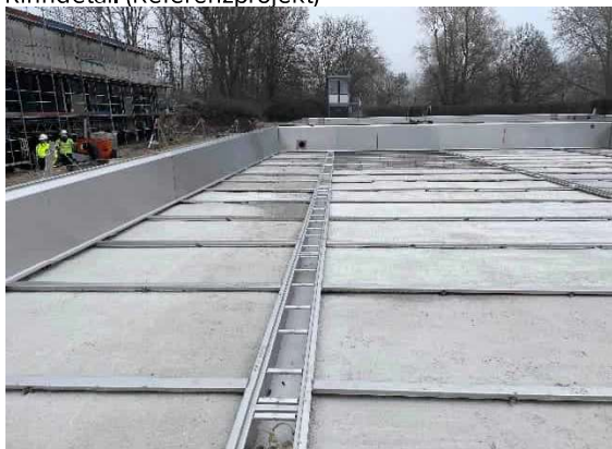
Einstromkanal (Referenzprojekt)
