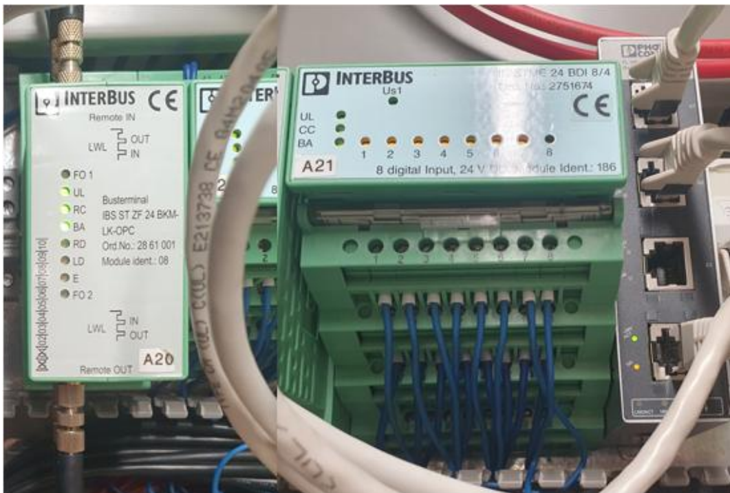
Abbildung 20: EA-Unterstation 2 mit den Interbuskomponenten 1x8xDI
