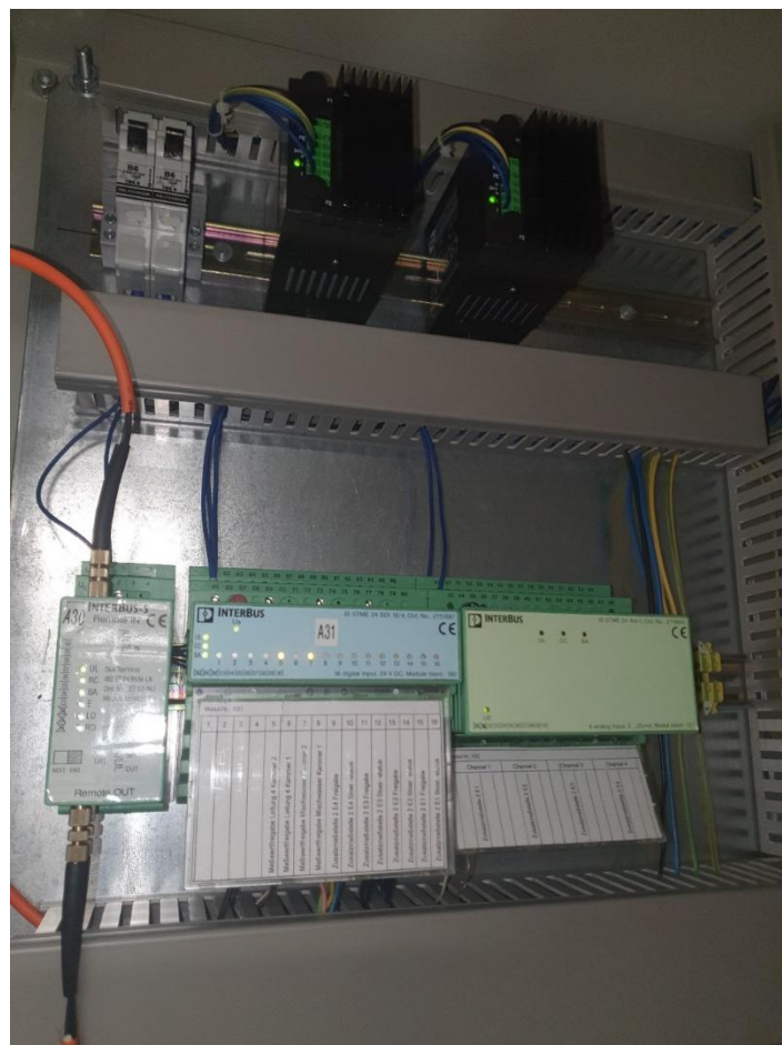
Abbildung 22: EA-Unterstation 3 mit den Interbuskomponenten 1x16xDI, 1x4xAI
