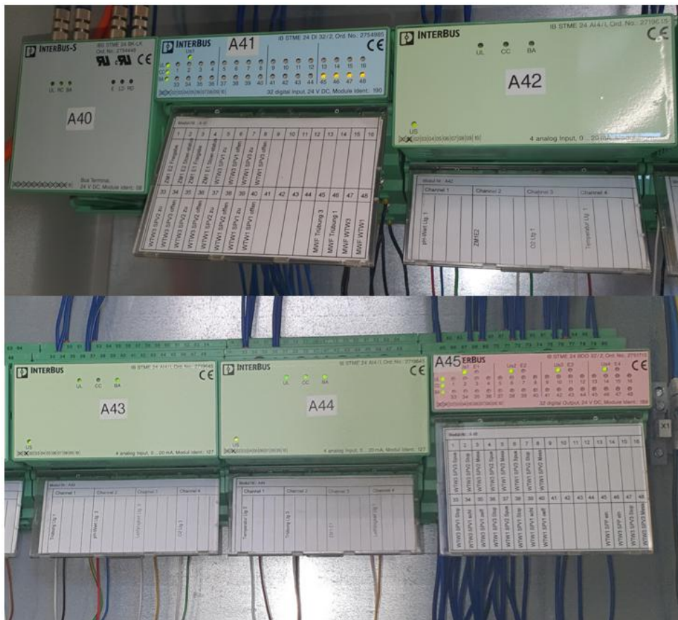
Abbildung 24: EA-Unterstation 4 mit den Interbuskomponenten 1x32xDI, 3x4xAI, 1x32xDO
