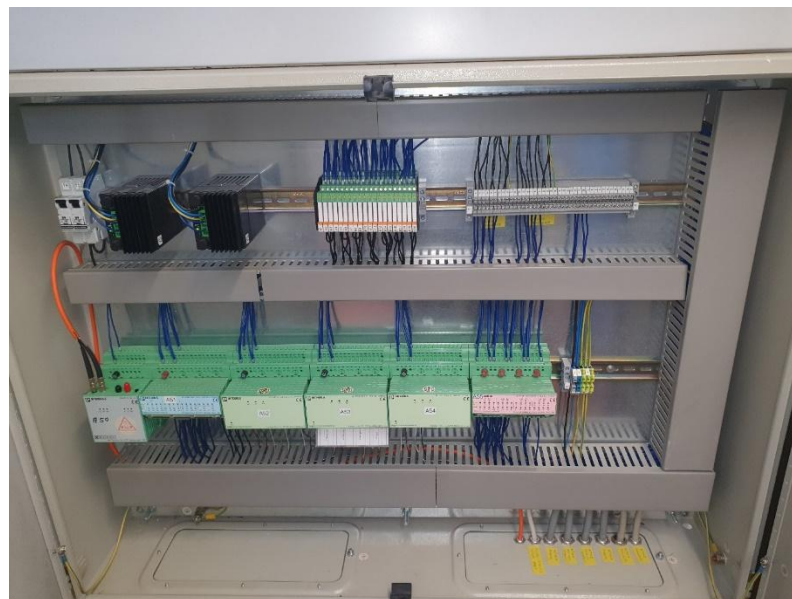
Abbildung 26: EA-Unterstation 5 mit den Interbuskomponenten 1x32xDI, 3x4xAI, 1x32xDO
