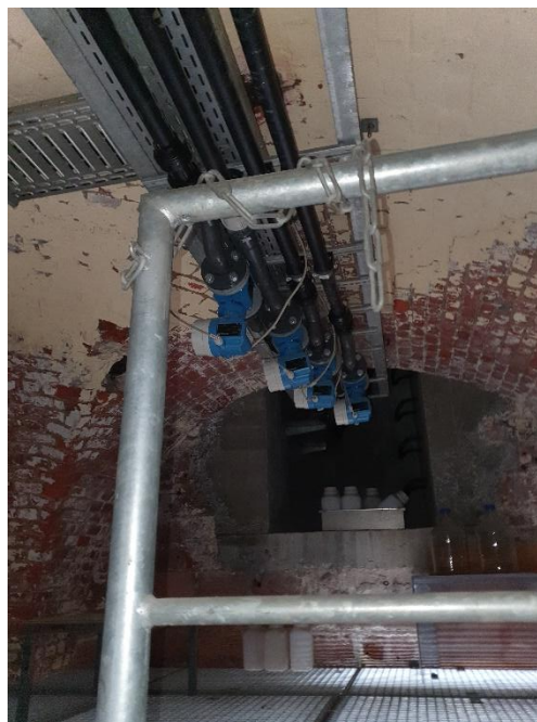
Abbildung 13: Durchflusssmessungen (MIDs) der vier Messwasserleitungen (BR)
