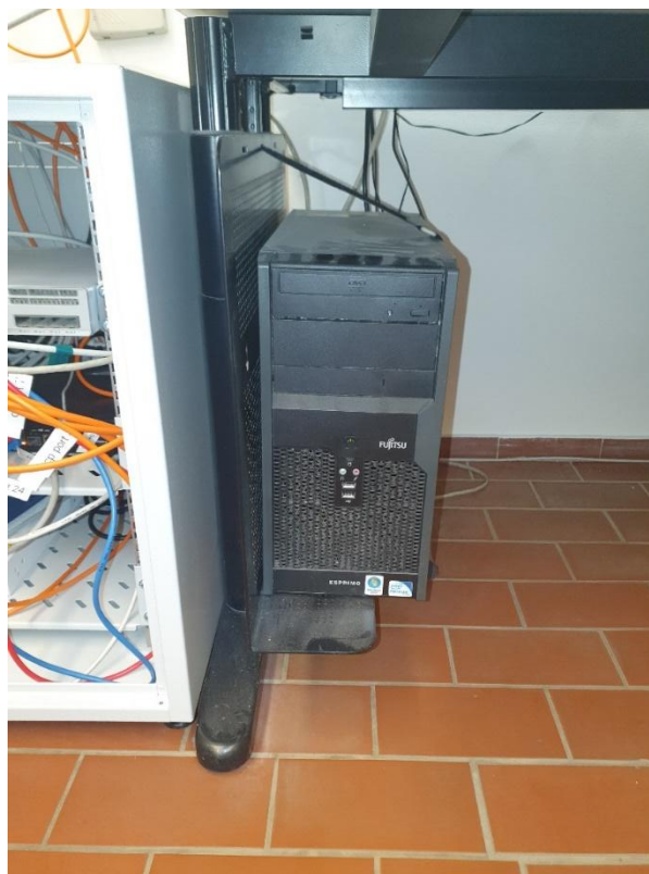
Abbildung 14: Dedizierter Server mit Software-SPS Incontrol, PLS-Software Intouch und PCI-Baugruppe (EG)
