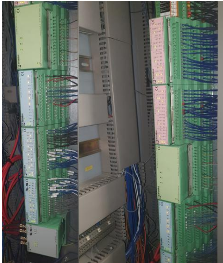
Abbildung 18: EA-Unterstation 1 mit den Interbuskomponenten 2x32xDI, 1x16xDI (siehe links), 1x4xAI, 2x32xDO (siehe rechts)
