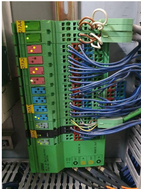
Abbildung 29:EA-Unterstation 6 mit Interbus Buskoppler und dessen Komponenten 1x16xDI, 2x2xAI, 1x8xDO
