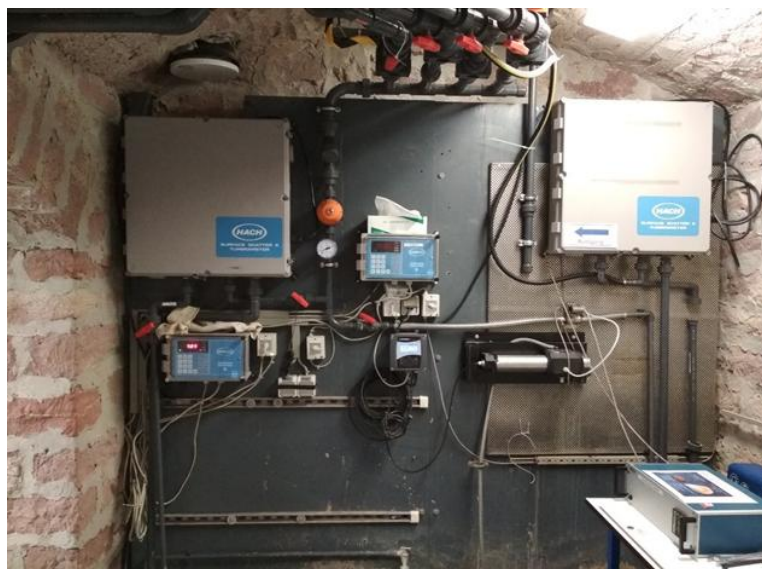
Abbildung 28::Chargenmessung mit den vier Einzelleitungen auf eine Sammelleitung
