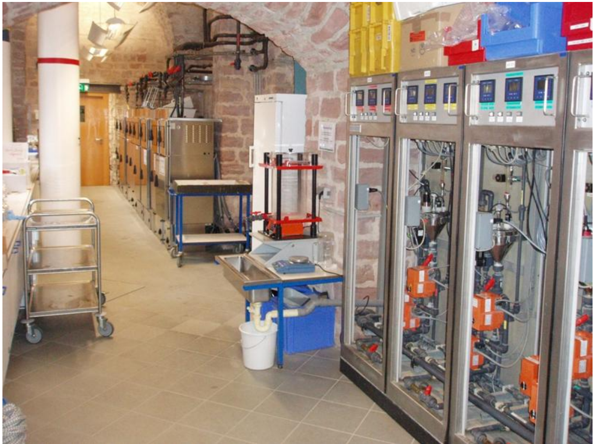
Abbildung 2: Innenansicht der Rheingütetestation Worms im Altbau mit Blick auf Probenahme (im Hintergrund) und kontinuierliche Messeinrichtungen (rechts im Vordergrund) der Station.
