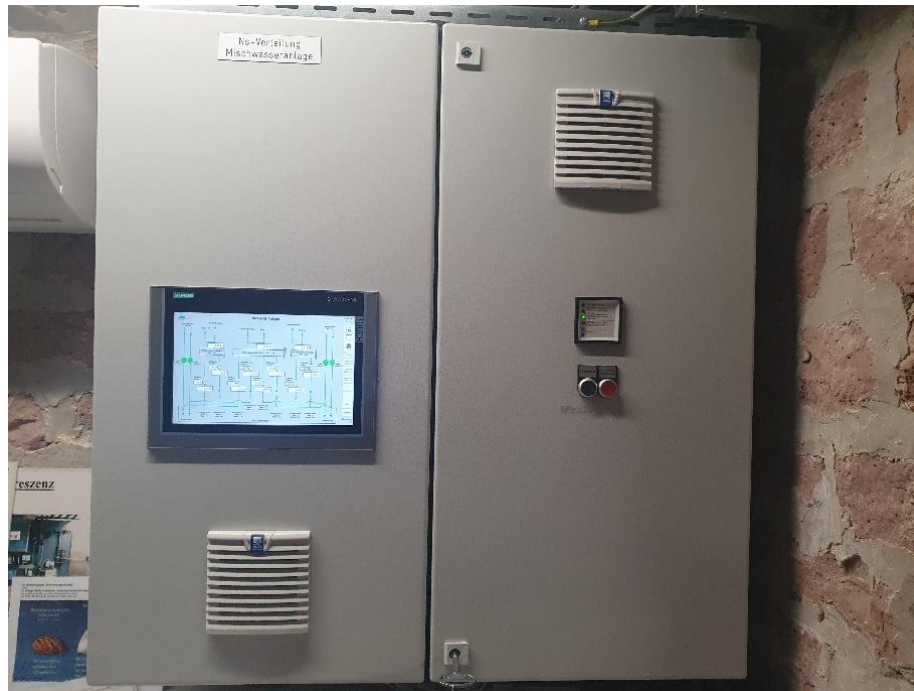
Abbildung 24: NS-Verteilung Mischwasseranlage
