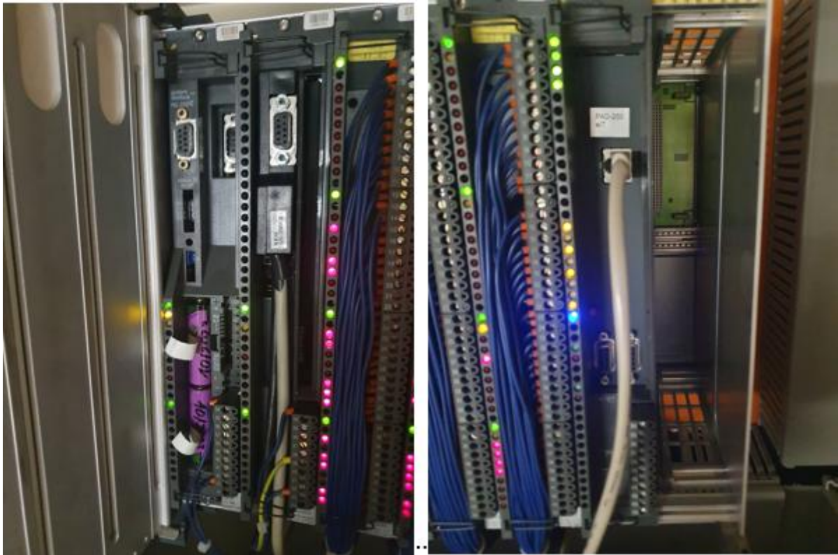
Abbildung 19: AEG Modicon A250 (BG1), Feldbus Koppler (BG2) und APEX PAD250 (BG 9)
