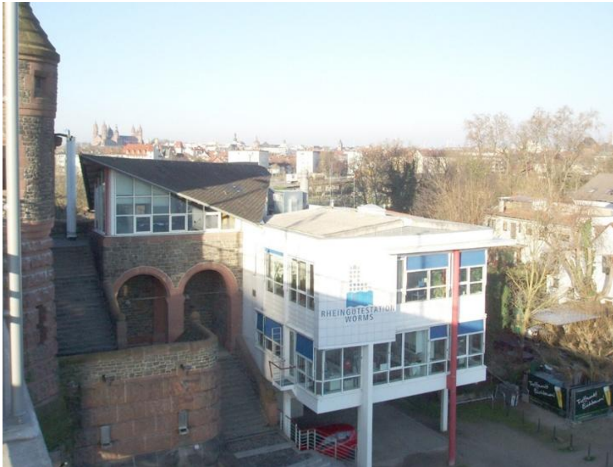
Abbildung 1: Außenansicht der Rheingutestation Worms mit Blick auf Neubauteil (rechts plus Schieferdachbereich oberhalb) und Teilansicht Altbau (links) der Station.
