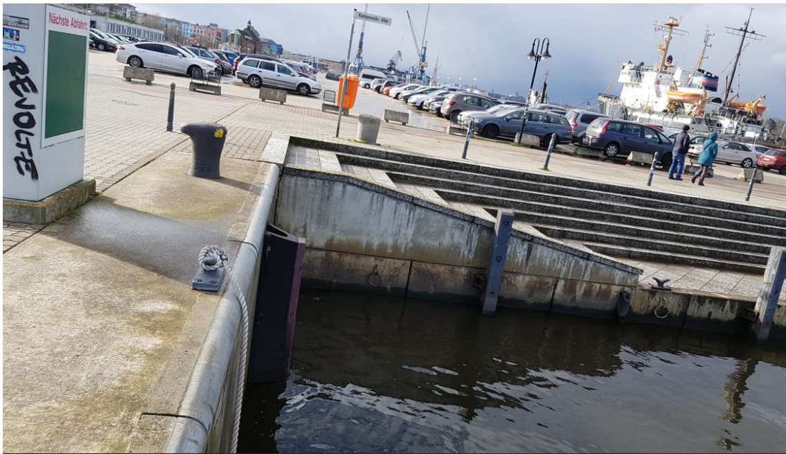
Stadthafen, Liegeplatz 83S Ecke Liegeplatz 84
