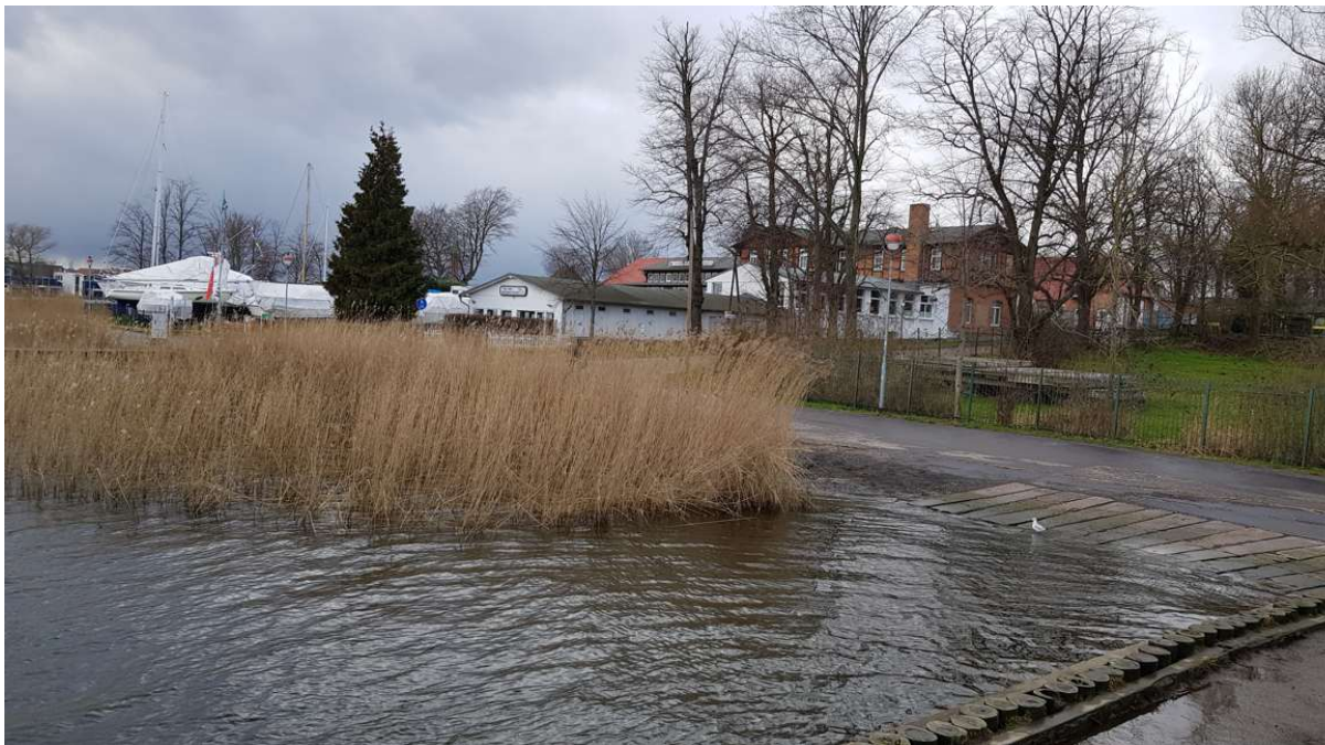
Gehlsdorf, Standort Steg vorhandene Slipanlage, Blickrichtung Fährhaus)
