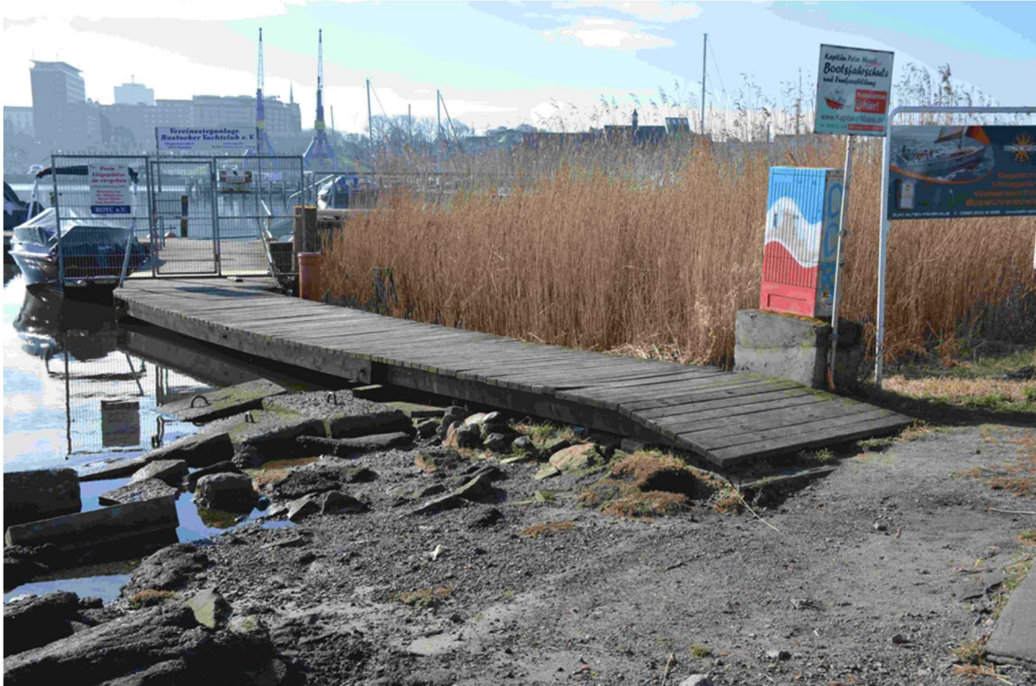
Gehlsdorf, Blick Richtung Steg ROYC (Foto vor Verlegung), Bereich zukünftiges Widerlager Nord
