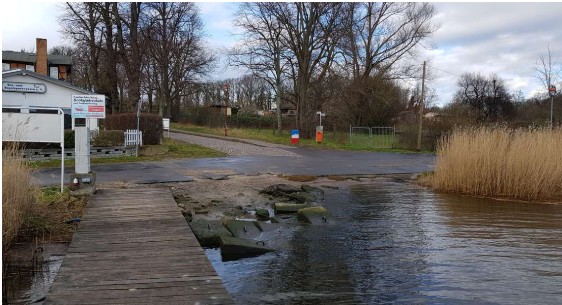
Gehlsdorf, Fotostandort Steg ROYC (Foto vor Verlegung, Steg links im Bild), Blick Richtung Straße Am Fährlberg, Bereich zukünftiges Widerlager Nord
