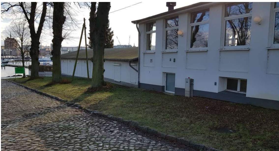
Gehlsdorf, Straße Am Fährlberg, Blick Richtung Ufer, Fährhaus
