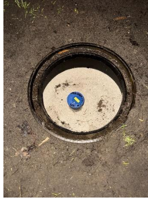
RFP 1/25 - Abschluss des Pegelrohrs mit einer Kompaktkappe (Foto: Vormann & Partner, 28.02.2025)
