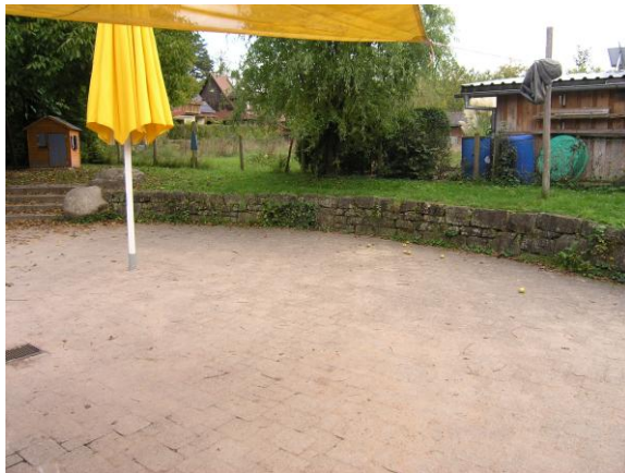
Zu sichernde und wieder zu verwendende Sandstein-Quadermauer
