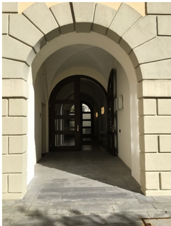
6. Durchgang zum neuen Aufzugsturm
