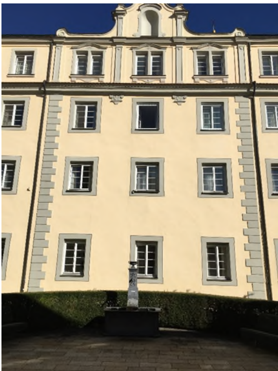
5. Standplatz Bauaufzug und Treppenturm
