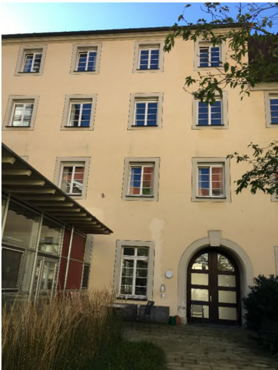
9. Fassade neue Zugänge zu den Geschossen
