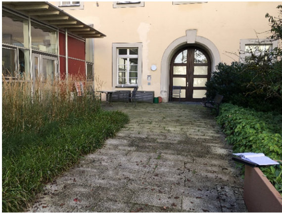
7. Bereich neuer Aufzugsturm
