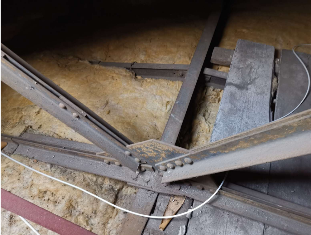
Knotenpunkt Stahldachstuhl
