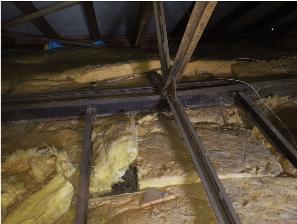
Tunterspannung Stahldachstuhl
