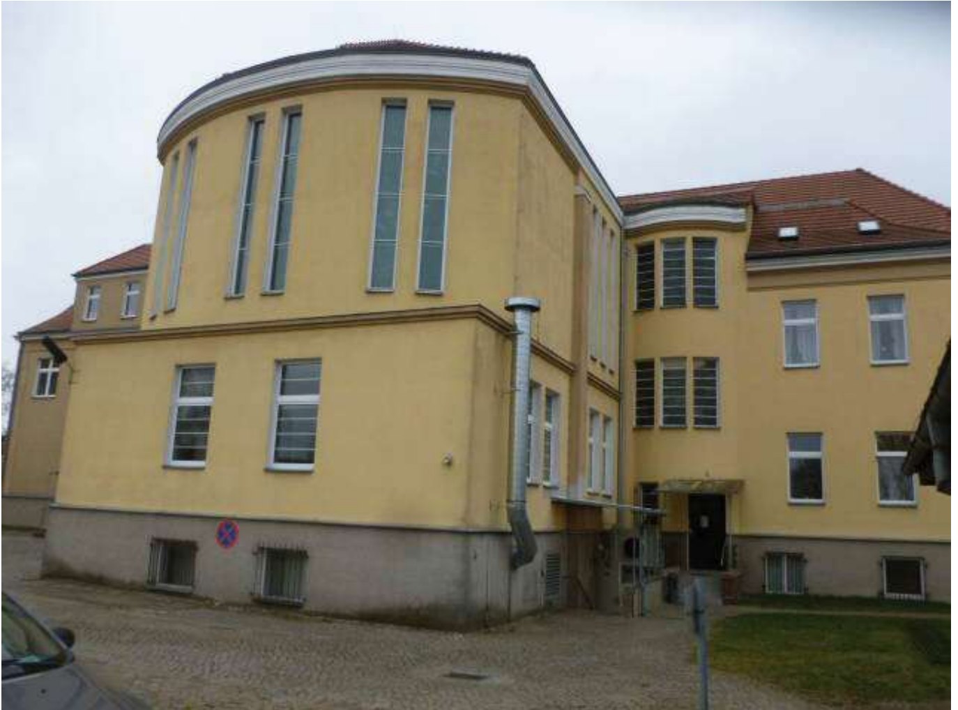
Ansicht Saaltrakt Ansicht Nord-West mit vorhandenen Zugängen-Vordächern
