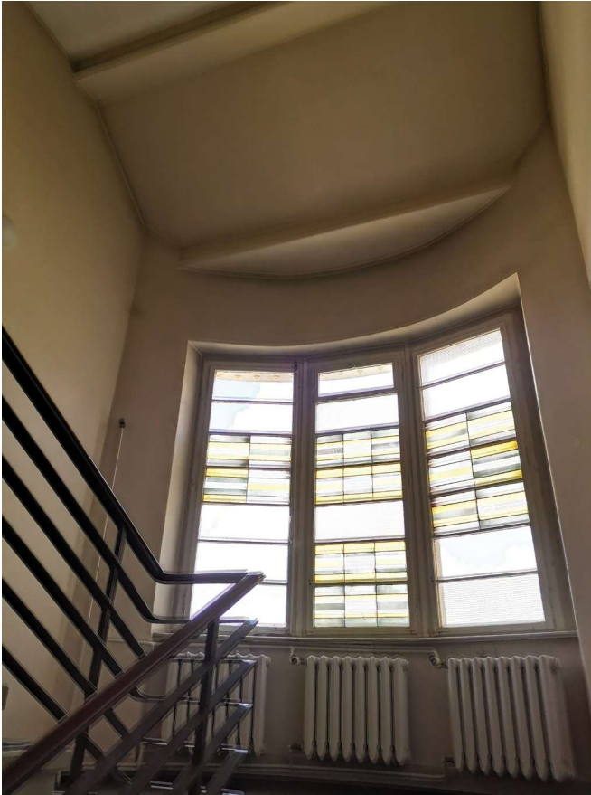
Treppenkopf West- zu verstärkender Unterzug
