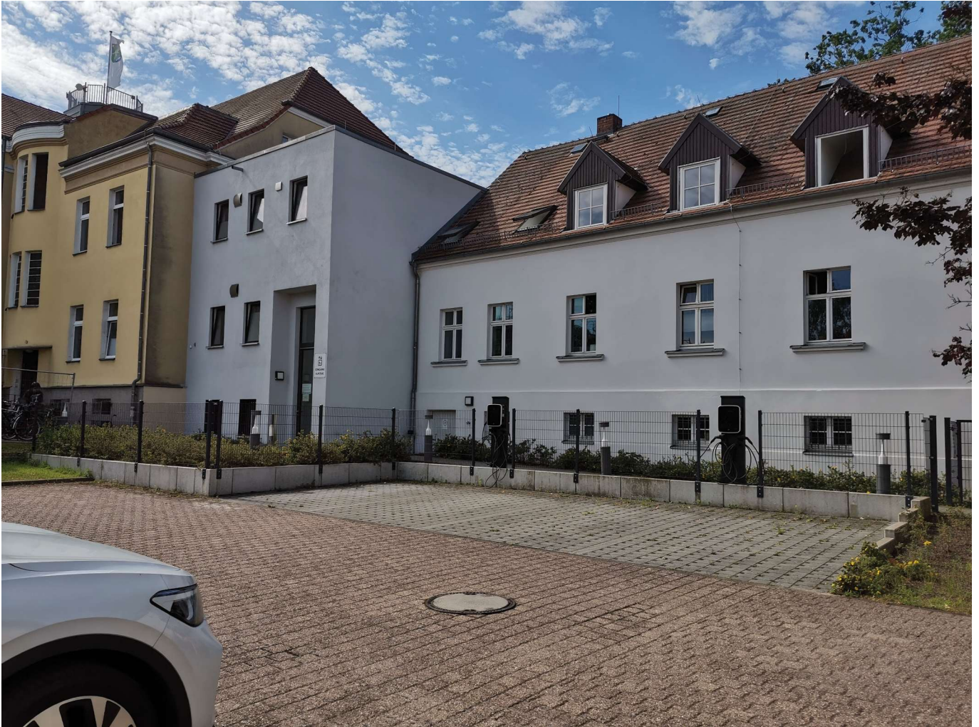
Angrenzende Bauwerke - Verbinder+ Haus D in Nutzung - Wandwange Treppenhaus über Dach
