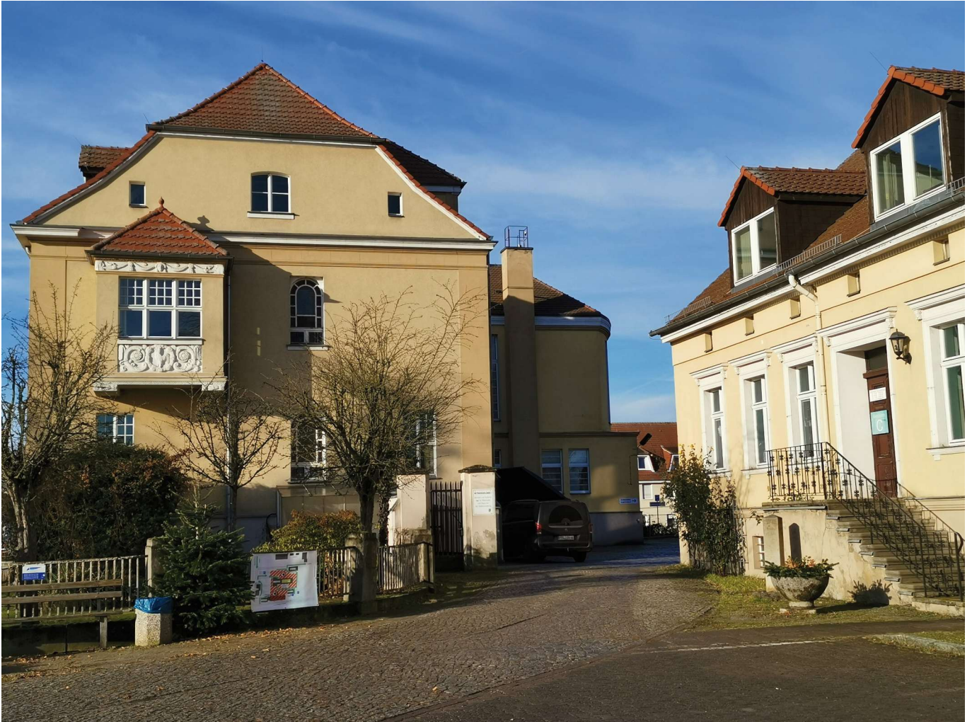
Zufahrtsbereich mit Tor-Pfeileranlage und Haus C (in Nutzung)
