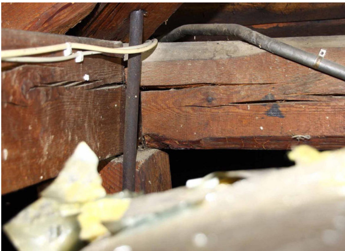
Bild 18: Querschnitt in der nördlichen Pfette oberhalb des Hängewerks II;
