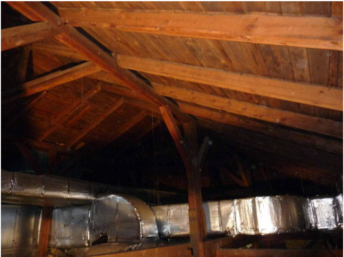
Bild 2: Blick in die Firstregion der Dachkonstruktion des Hauptgebäudes;
