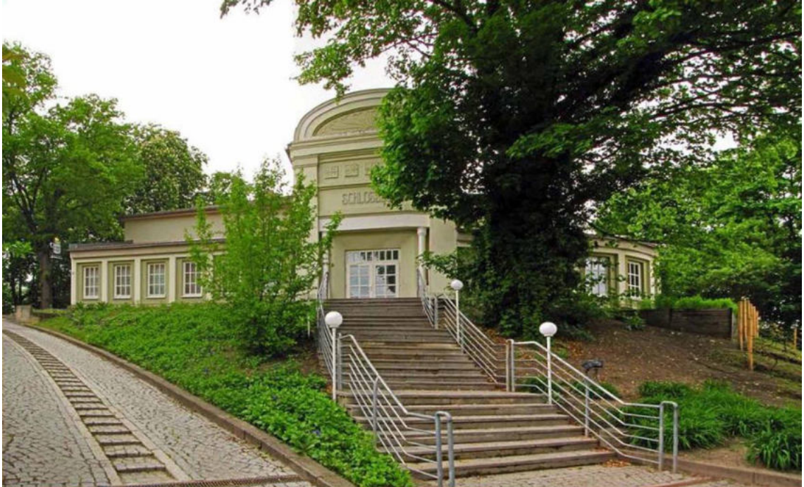
Bild 1: Ansicht des Untersuchungsobjektes von der Südseite;
