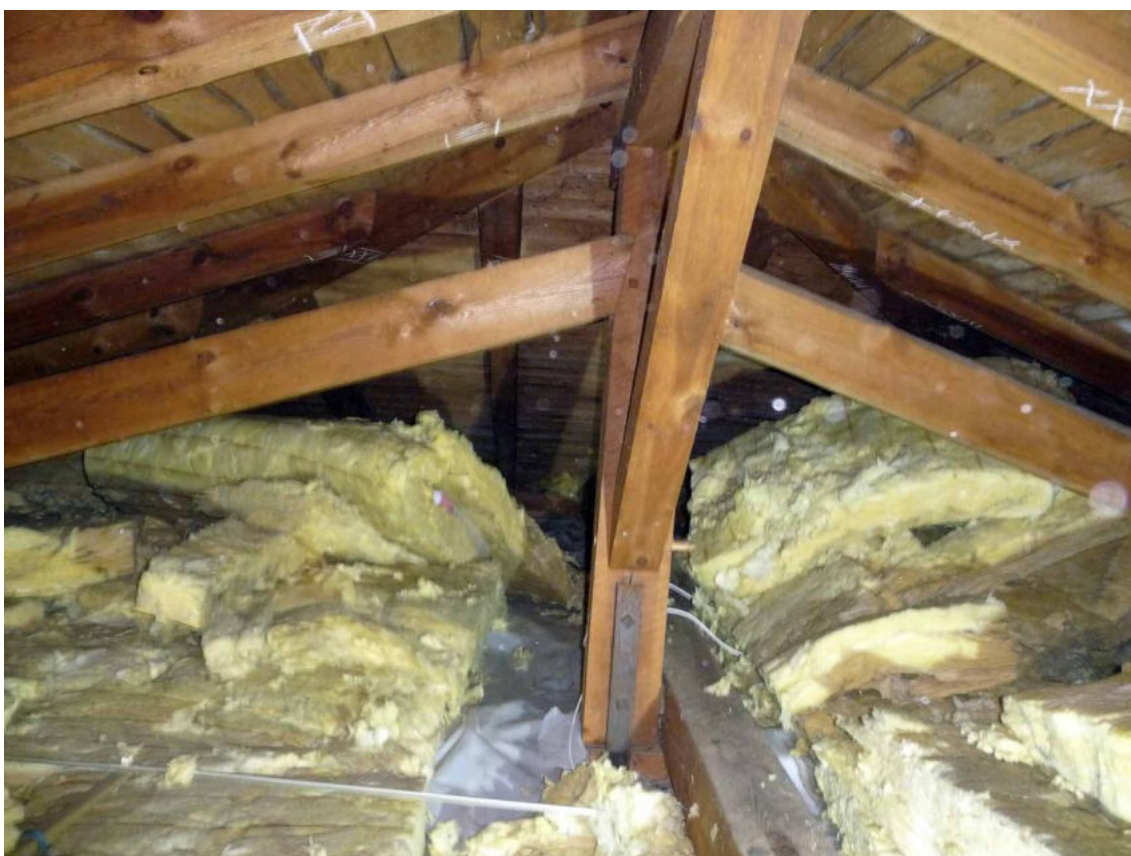
Bild 4: Blick in die Dachkonstruktion des nordseitigen Anbaus;
