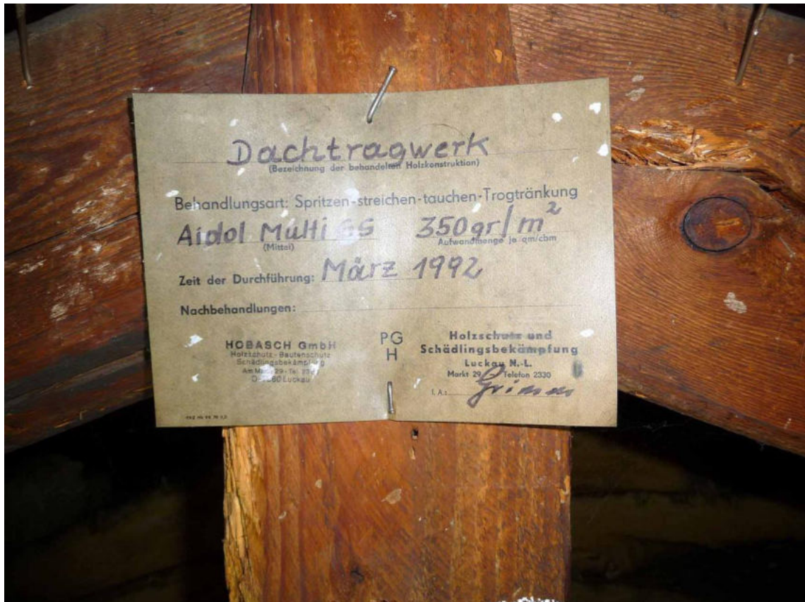
Bild 19: Informationstafel zur Holzschutzmittelbehandlung im März 1992 am Tragwerk des Hauptgebäudes;
