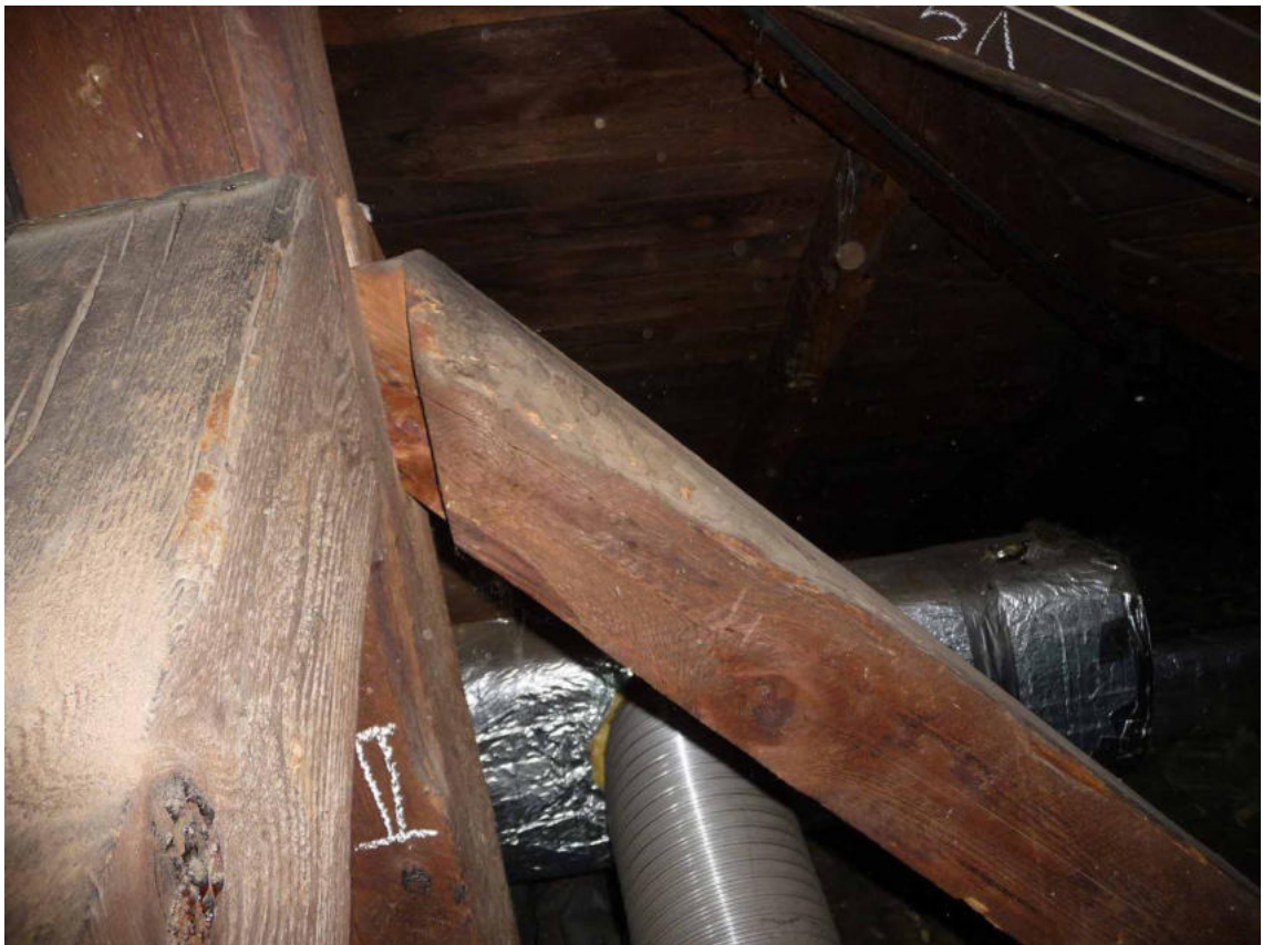
Bild 21: Gelöste rückseitige Stuhlstrebe (nicht Hängestrebe!) am Hängewerk II;
