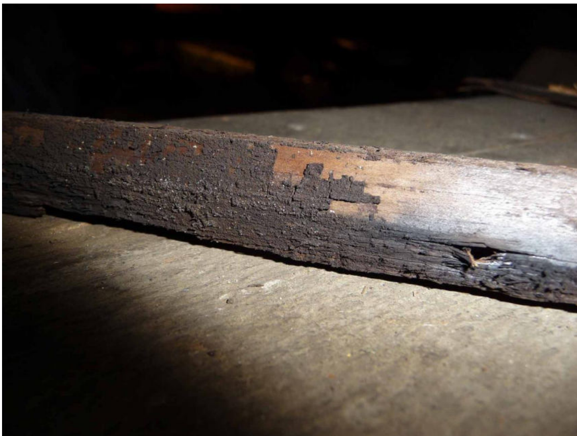
Bild 11: Detail aus Bild 10 mit deutlich erkennbarer Krustenbildung;
