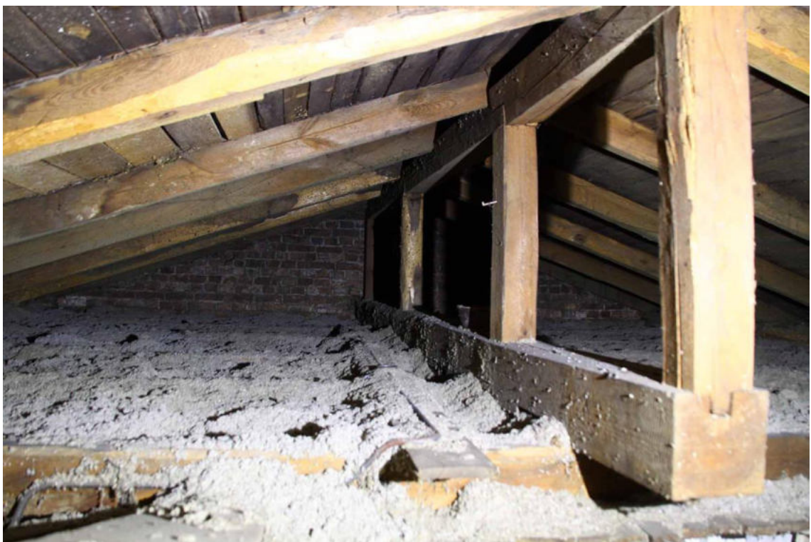
Bild 24: Dachkonstruktion oberhalb des Eingangsbereiches; Die Konstruktion ist optisch schadensfrei.
