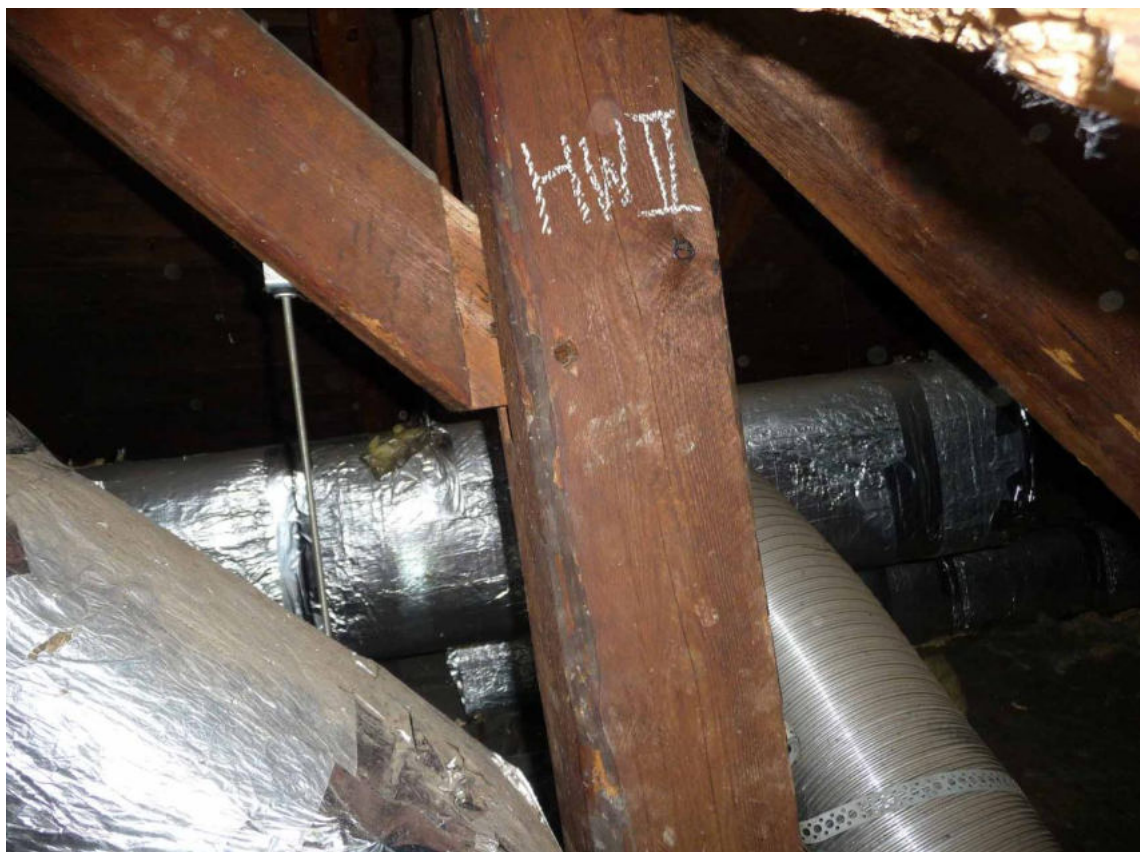
Bild 20: Gelöstes Kopfband an der Hängesäule des Hängewerks II;
