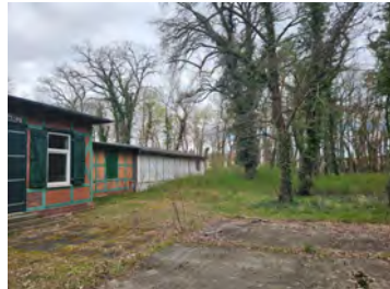
BE Trinkhalle (vorh. Betonfläche)
