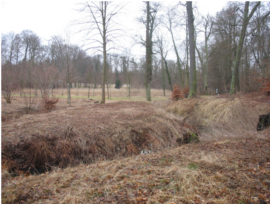
Graben nördlich der Egeria Grotte mit höherer und steilerer Böschung. Februar 2012
