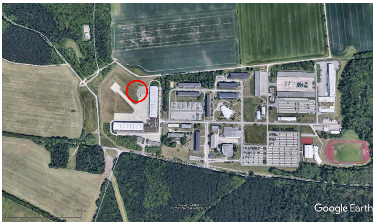
Abbildung 1: Untersuchungsgebiet / Erweiterungsneubau (roter Kreis)
