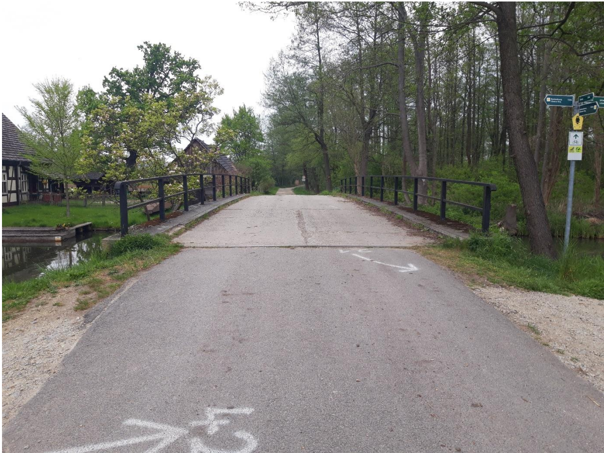
Abbildung 2: Bestandsbauwerk (05.05.2022, ohne Maßstab)
