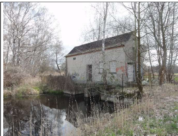
Foto 7: B - Blick vom befestigten Weg am Mahlbusen zum Schöpfwerk nach Südosten
