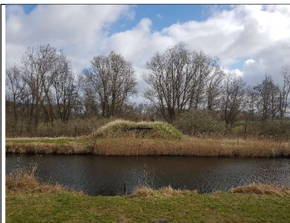
Foto 1: A - Blick auf das rechtsseitige Brückenwiderlager mit Entnahmestandort am rechten Rand.
