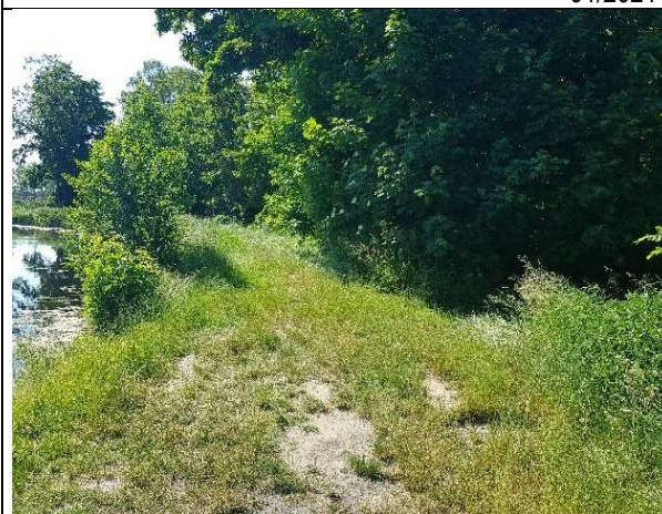
Foto 17: B - Blick nach Norden vom Stauhaltungs- damm
