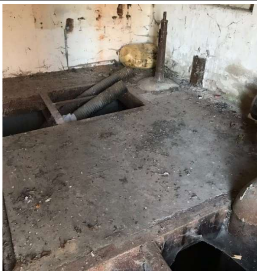
Foto 9: B - Innenansicht Schöpfwerk
