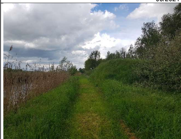
Foto 5: A - Verwallung in Richtung ehem. Brücke; ca. Entnahmestandort
