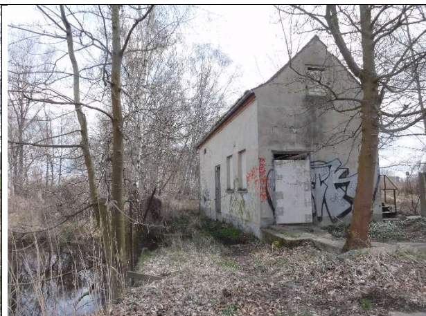
Foto 8: B - Blick zum Schöpfwerk nach Osten
