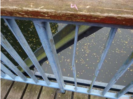
2023H-GEL - FÜLLSTAB VERBOGEN
