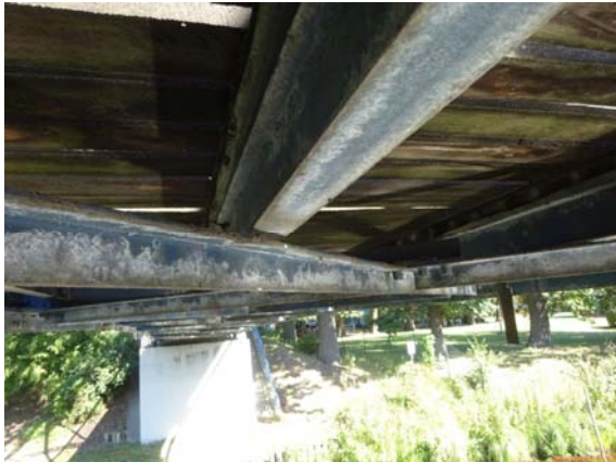
2023H-FW - ZINKKORROSION
