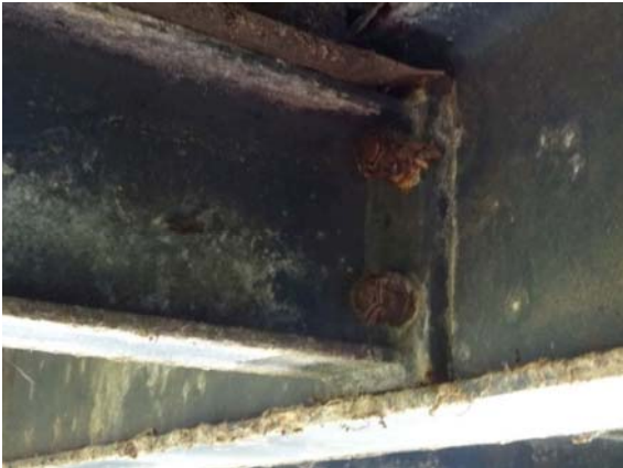
2023H-FW - SCHRAUBEN ANGEROSTET
