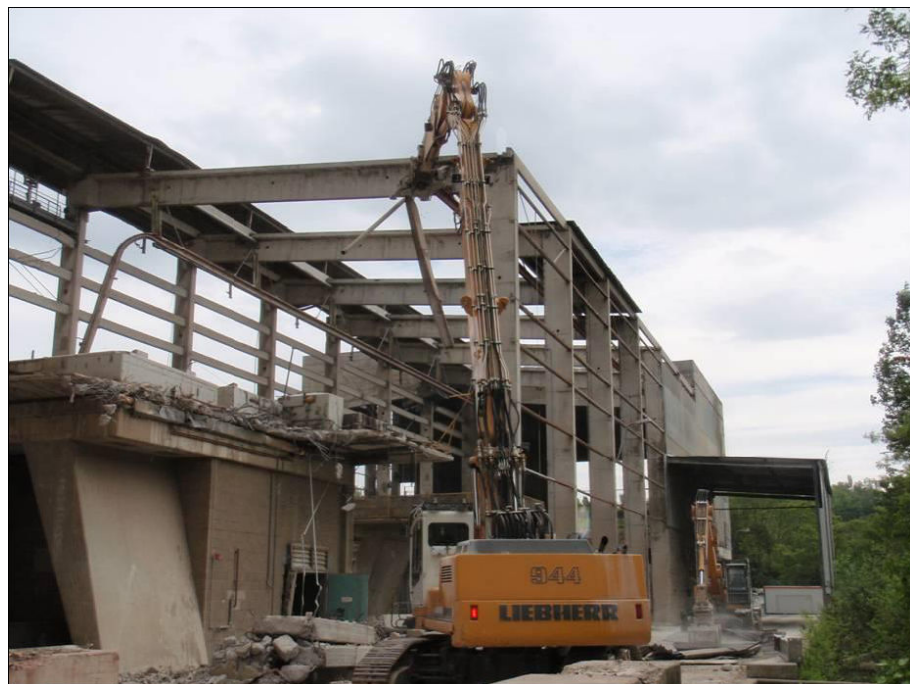
Abb. 2: Beispiel für einen Hallenabriss mittels Longfrontausleger und Anbaugeräten
