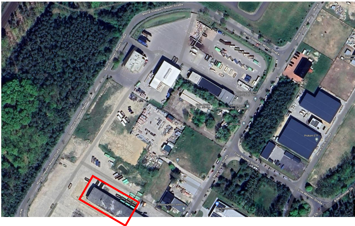
Abb. 1: Standort der rückzubauenden Mehrzweckhalle [Quelle: BRANDENBURGVIEWER]
