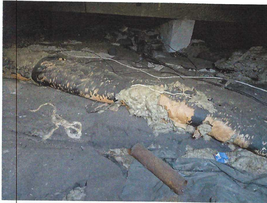
Abbildung 7: Blick in den Drempegel – Kamilitdämmung AVV 170603* - beispielhaft
