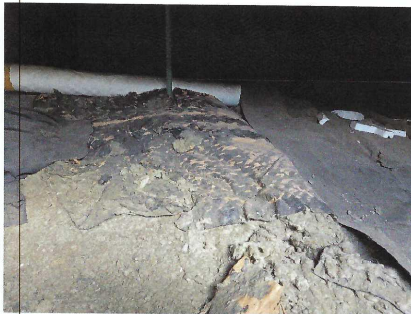
Abbildung 16: Drempeldämmung AVV 170603* mit AVV 170903*
