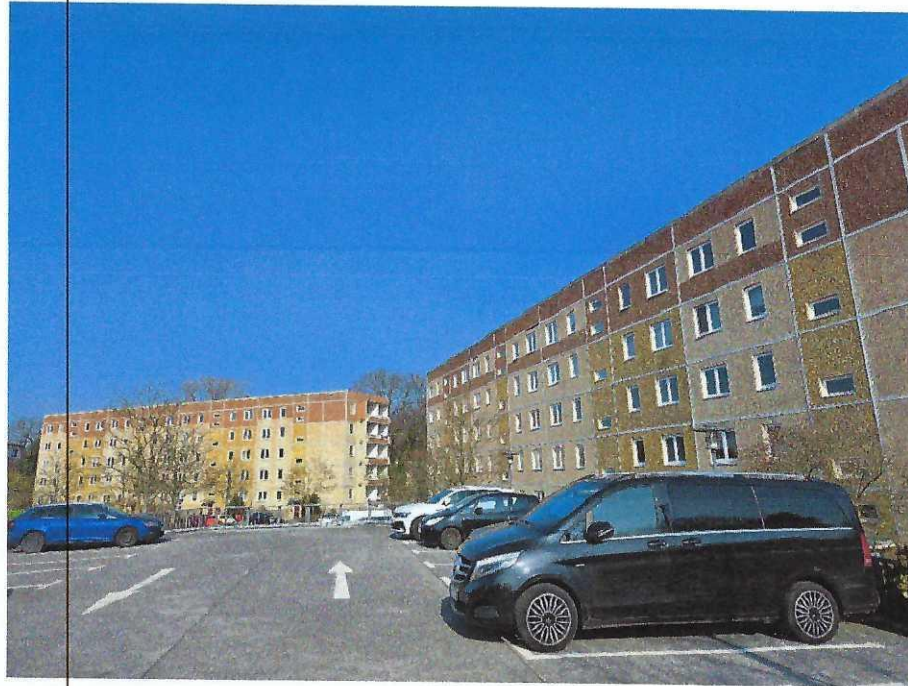
Abbildung 1: Ansicht aus Richtung Süden, Eingangsseite
