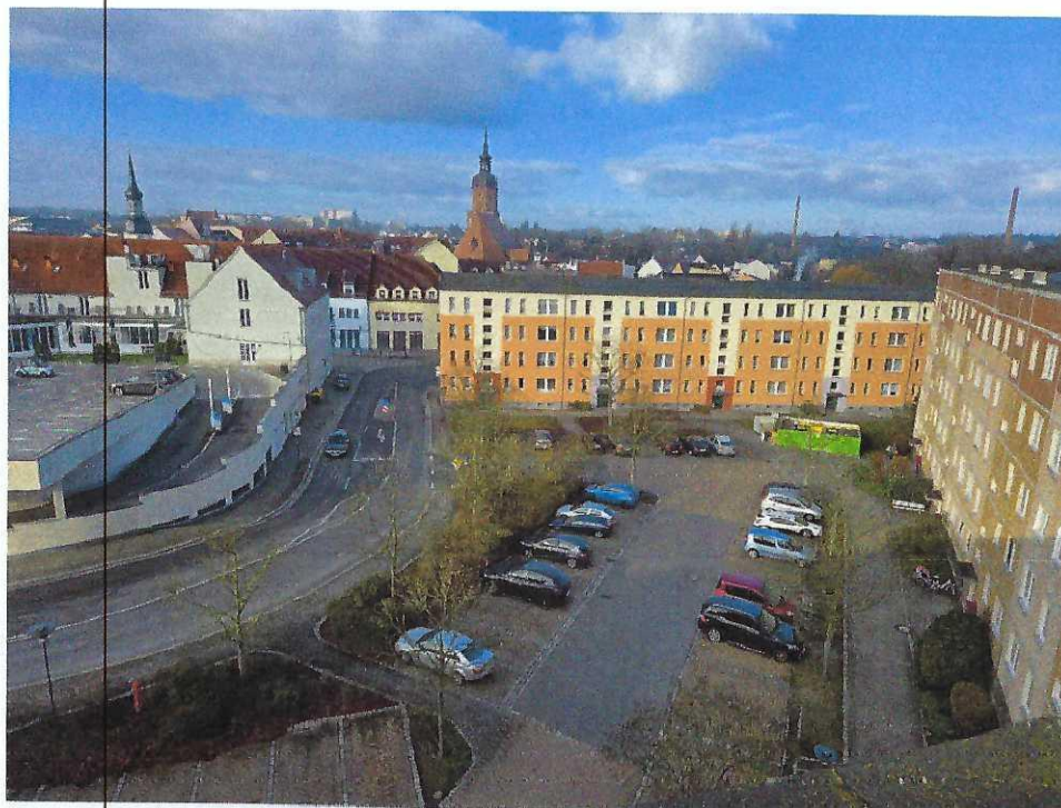
Abbildung 15: Teilansicht abzubrechende befestigte Flächen im Außenbereich
