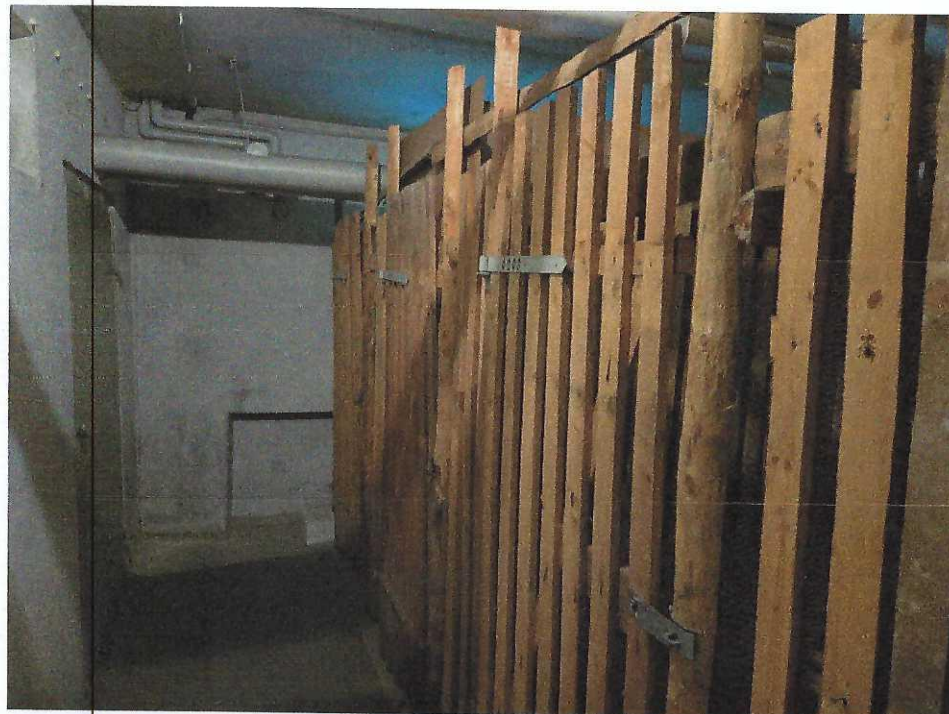
Abbildung 13: Blick in den Kellerbereich
