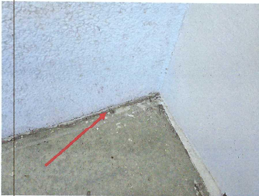
Abbildung 4: Morinolfuge im Loggienbereich
