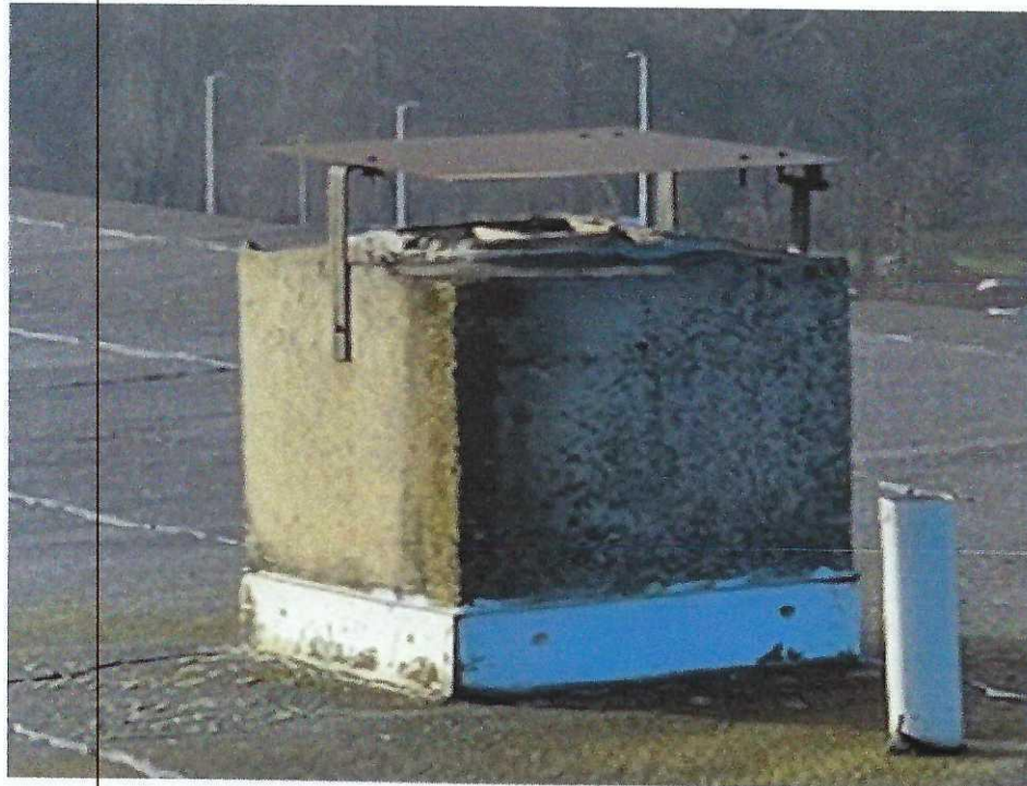
Abbildung 6: Detailansicht Lüftungsschächte Dachbereich
