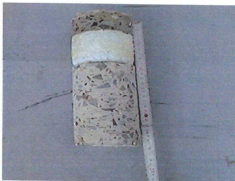
Abbildung 2: Bohrkern aus den Außenwandplatten
