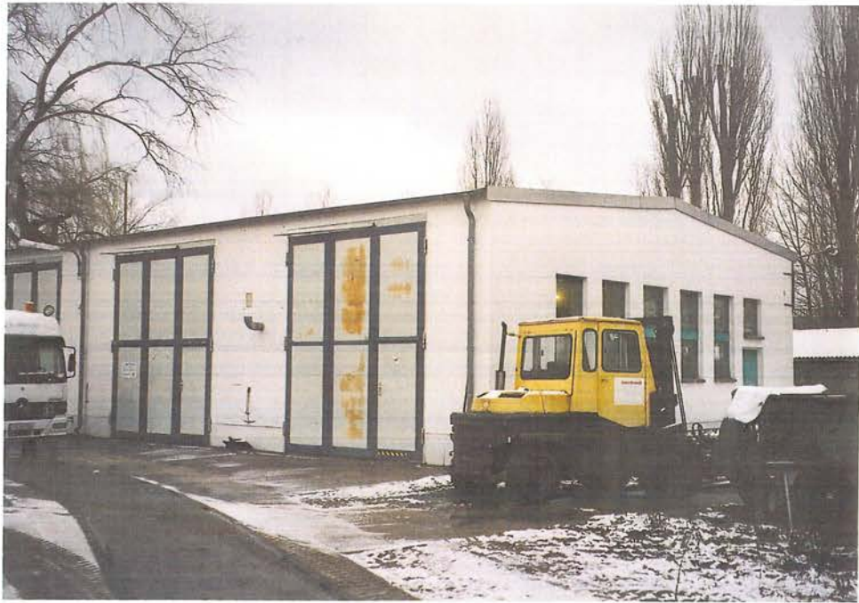
Gebäude 11, Ansicht von Südwesten
