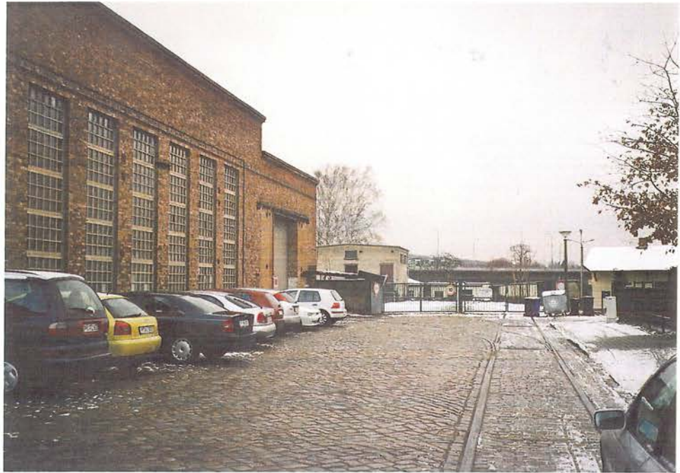
Außenfassade Türkstraße Blick nach Osten zur Wagenhalle (Gebäude 5) und zum Trafosgebäude (Gebäude 15 im Hintergrund)
