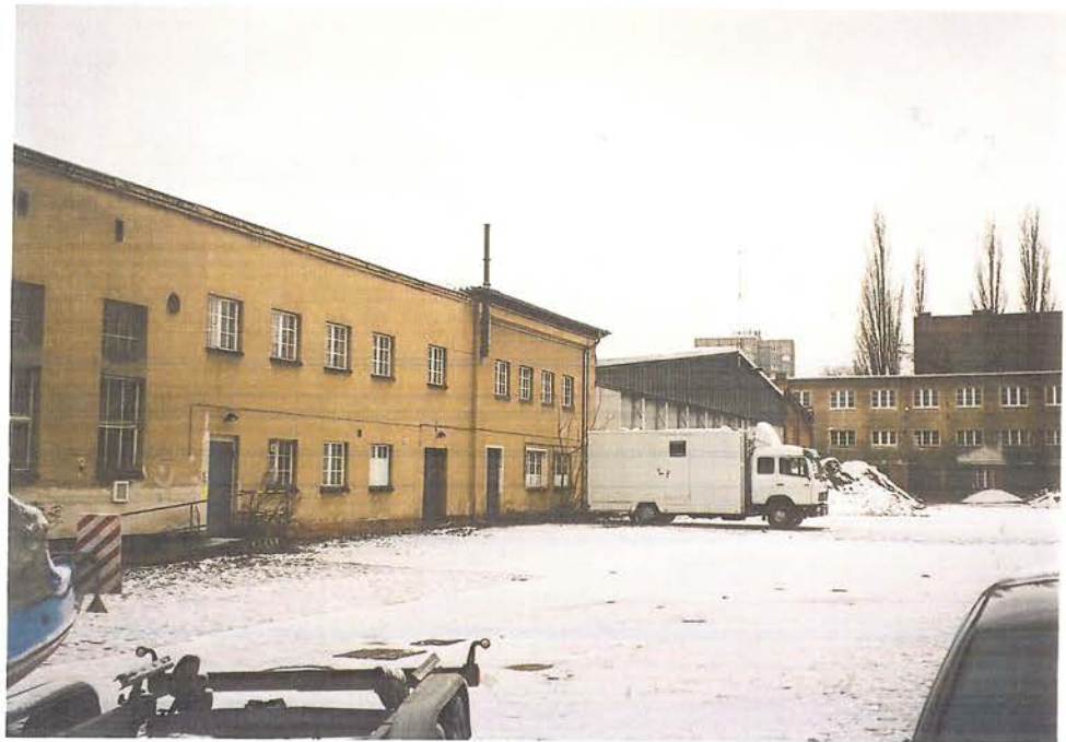
Hofansicht Blick nach Südwesten zum Verwaltungsbau (Gebäude 7), im Hintergrund Wagenhalle (Gebäude 5) sowie Betriebsgebäude (Gebäude 2)
