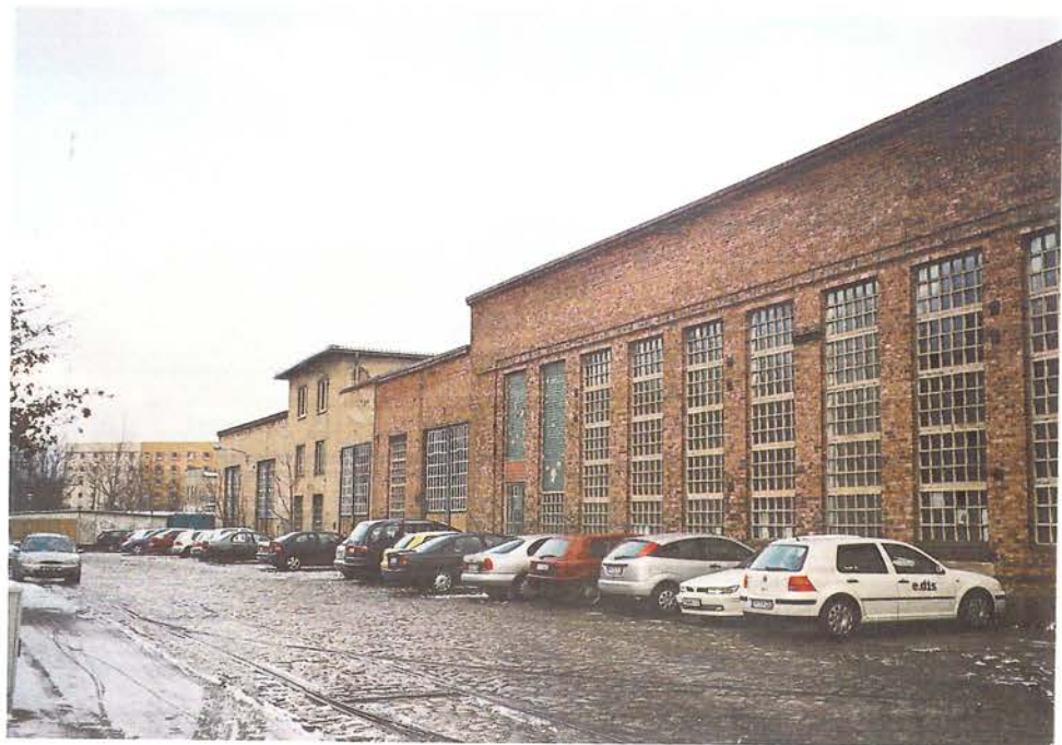
Außenfassade Türkstraße Blick nach Westen mit Wagenhalle (Gebäude 5) sowie Werkstätten (Gebäude 2 bis 4)
