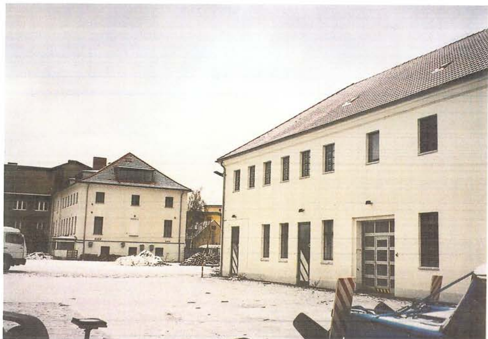
Hofansicht Blick nach Nordwesten zum Hauptgebäude (Gebäude 1), rechts Lager- und Betriebsgebäude (Gebäude 10)
