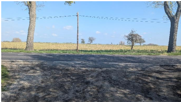
Abbildung 9: Blick nach Norden zur L 162 – Bereich der Schutzrohrpressung
