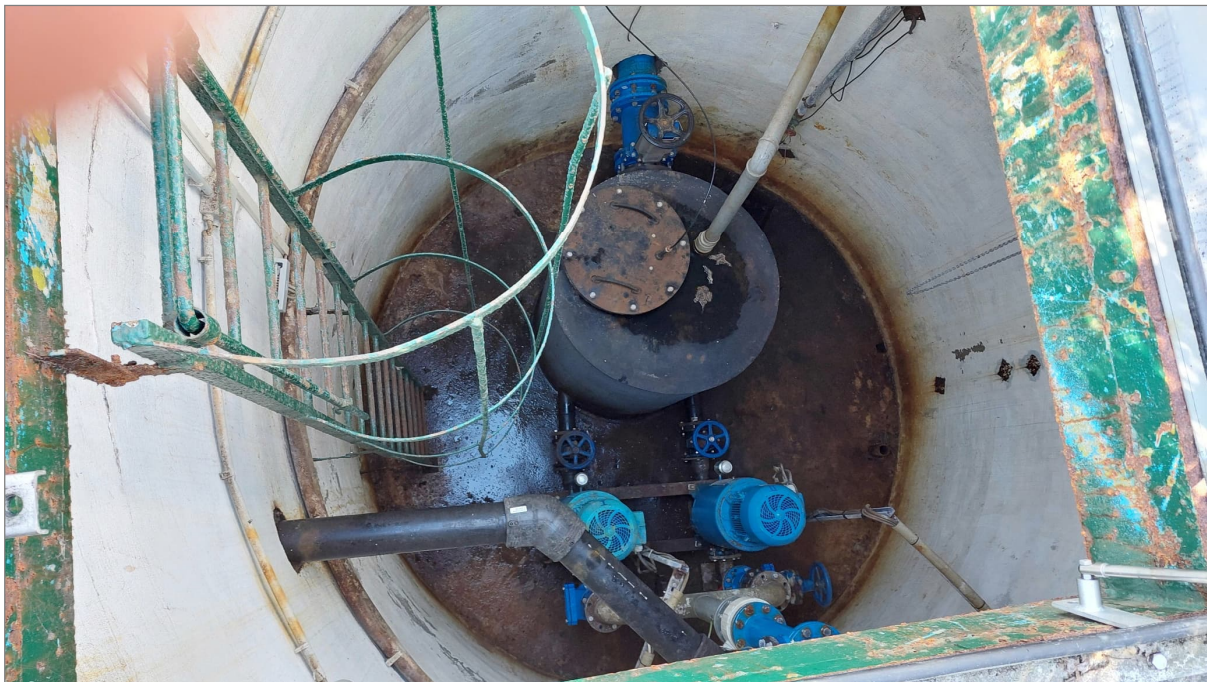
Abbildung 3.1: Innenansicht Pumpenschacht
