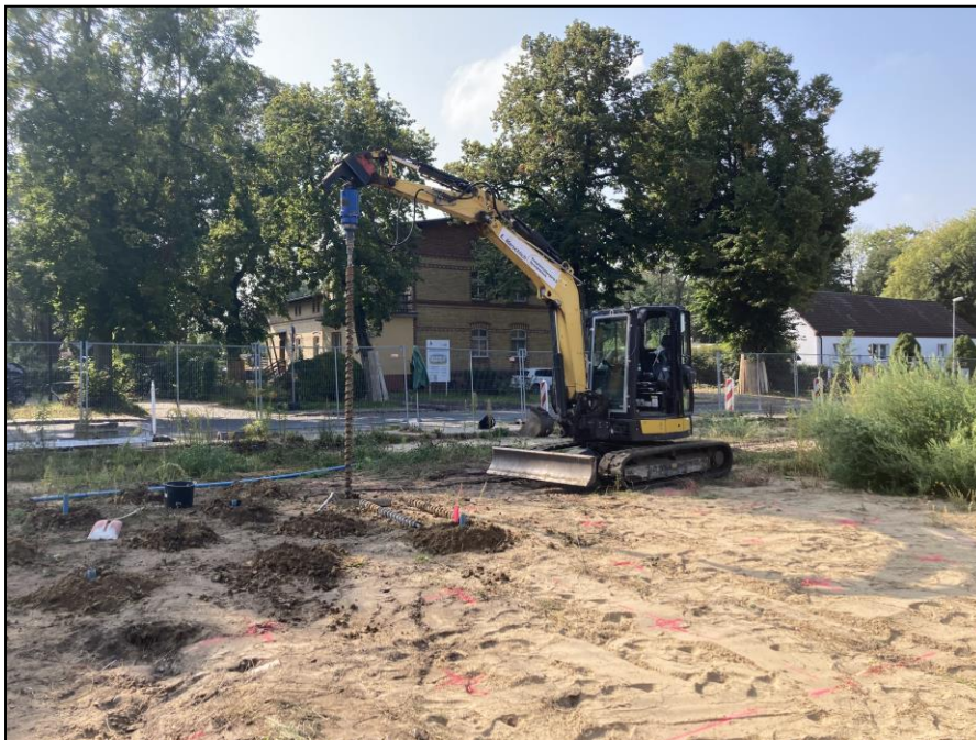
Abb. 2: Herstellung der Bohrungen mit nachfolgender Verrohrung
