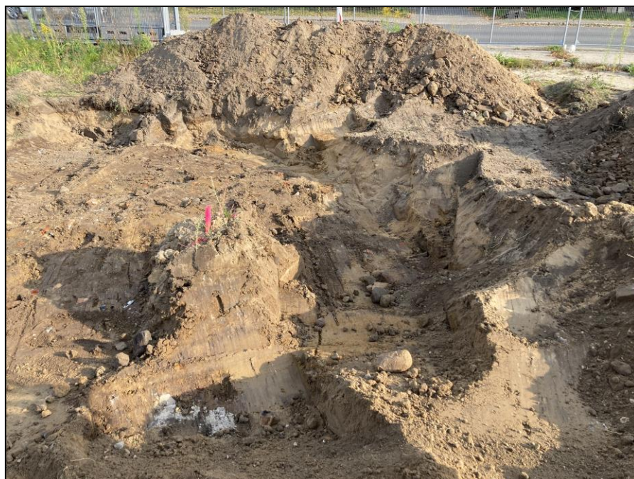
Abb. 6: Abgrenzung der trichterförmigen Verfüllung
