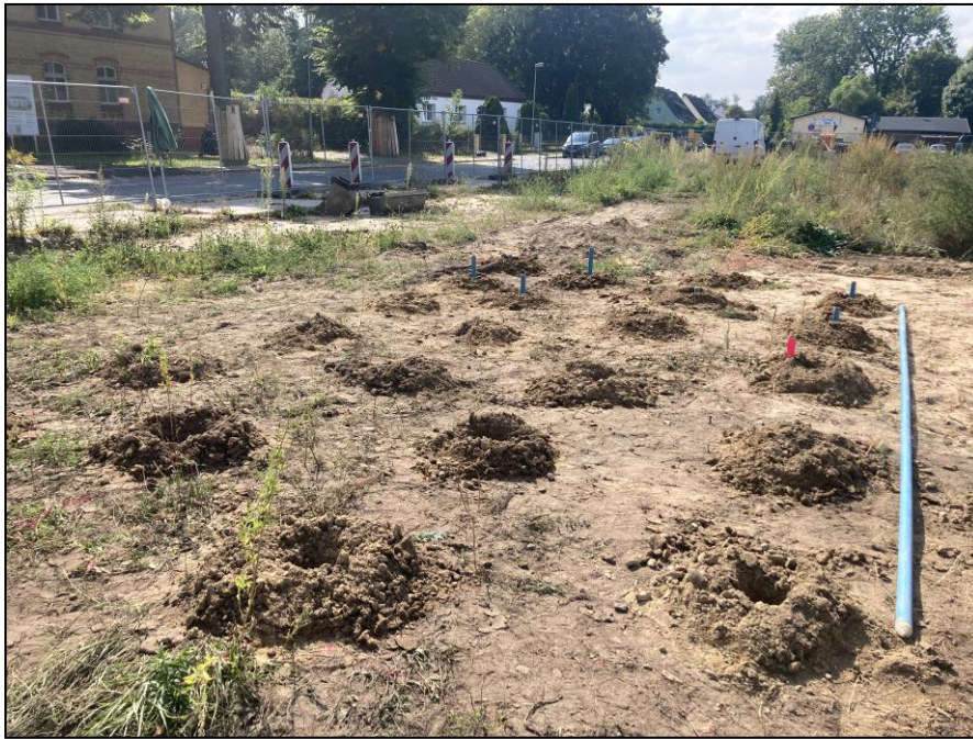
Abb. 3: Hergestellte Bohrlöcher zur nachfolgenden Messdatenaufnahme
