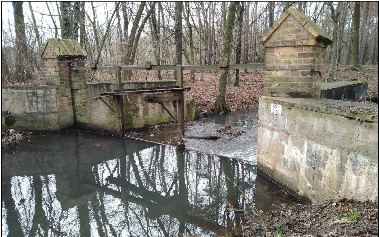
Abbildung 1: Bauwerk E in der Trantz (TRAM S18)
