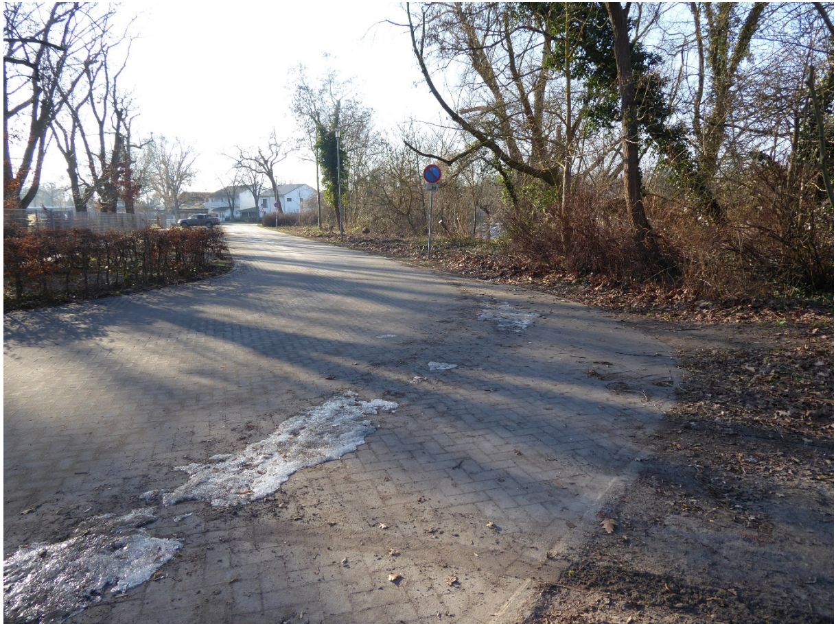
Schwedendamm, rechts die Baurasse (Blick von Nordosten)
