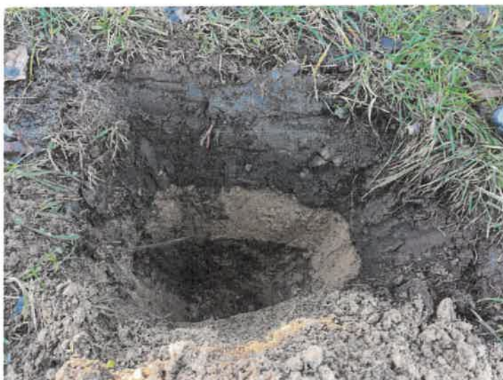
Abbildung 2: Schurf 2 bei Bohrung B2 auf der Dammkrone
