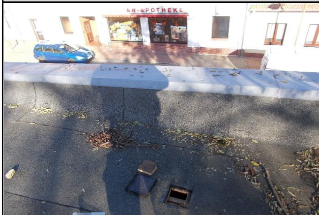
Blick auf den Probenahmeort Dach
