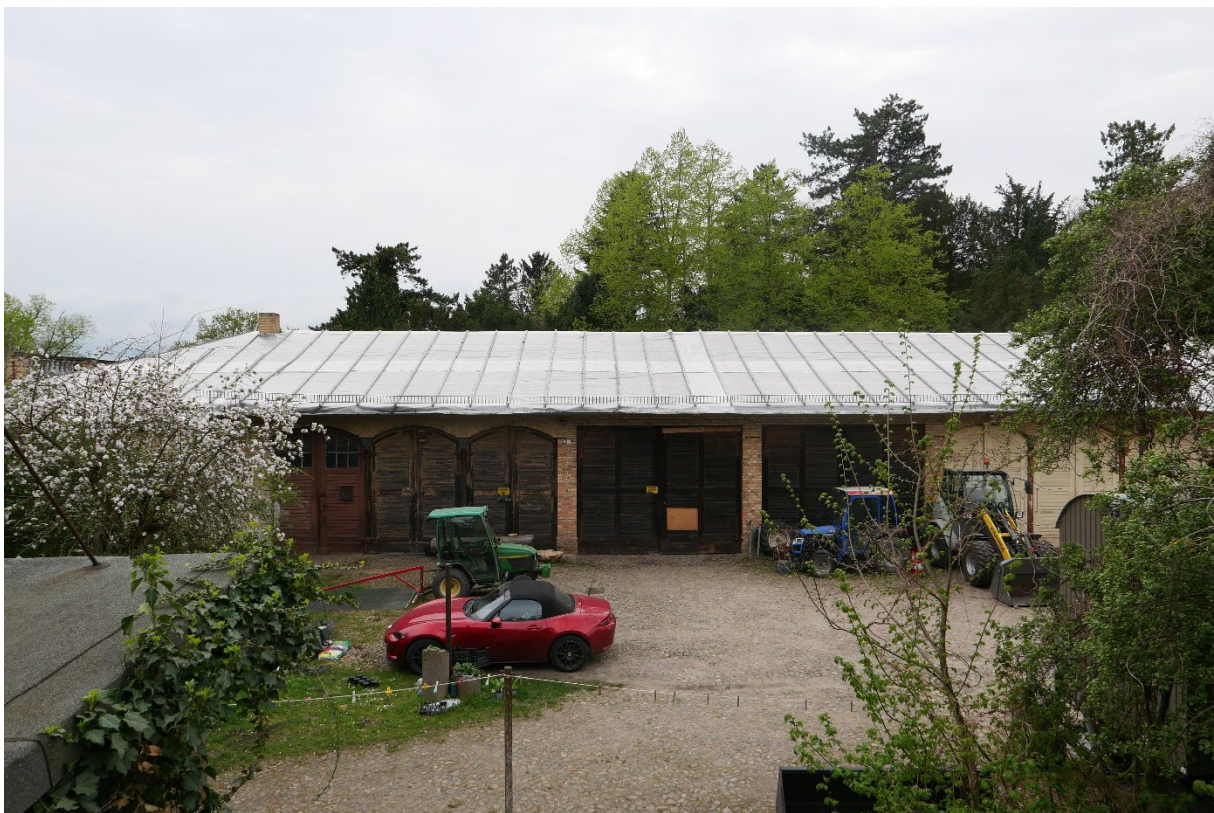
Abb. 4 - BE-Teilfläche, Remisenhof , Ansicht der Remise von der Ostseite
