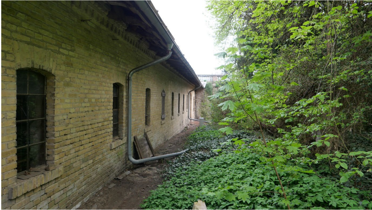
Abb. 5 - rückseitige Ansicht der Remise von der Westseite
