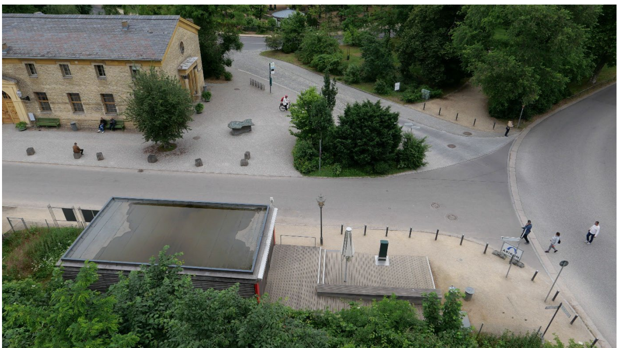
Abb. 2 – im Vordergrund Baufeld Schweizer Haus, Straße An der Orangerie , oben links das Marstall -Gebäude
