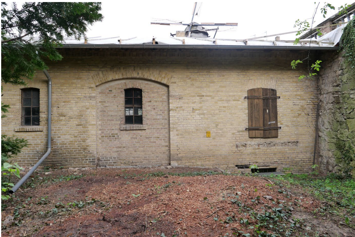
Abb. 6 - rückseitige Ansicht der Remise von der Westseite, rechts das Baufeld für den Anbau-West nach öffnen des vermauerten Torbogens ist der Zugangs auf das Baufeld Anbau-West frei
