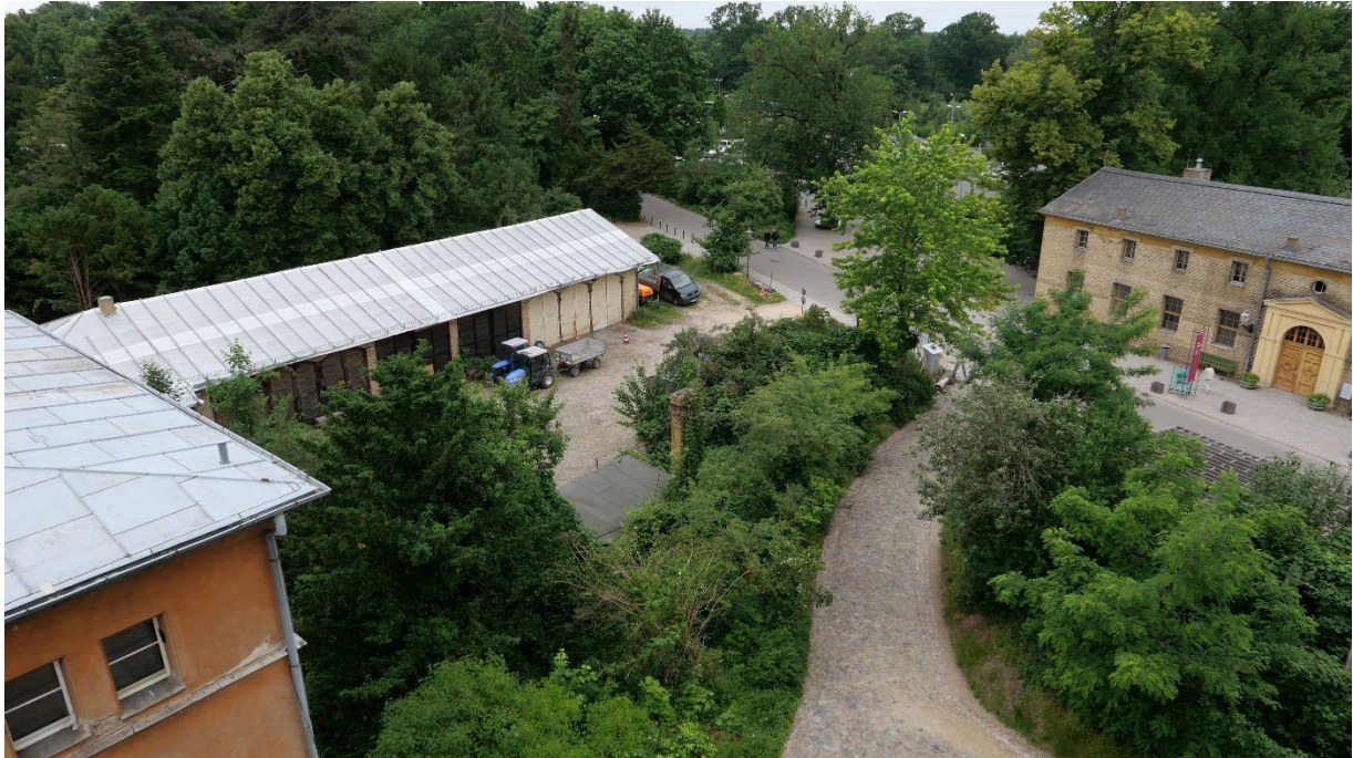
Abb. 1 - BE-Teilfläche MHK, Remisenhof , rechts davon die Rampe auf das Mühlenplateau , hinten Straße An der Orangerie und Marstall -Gebäude
