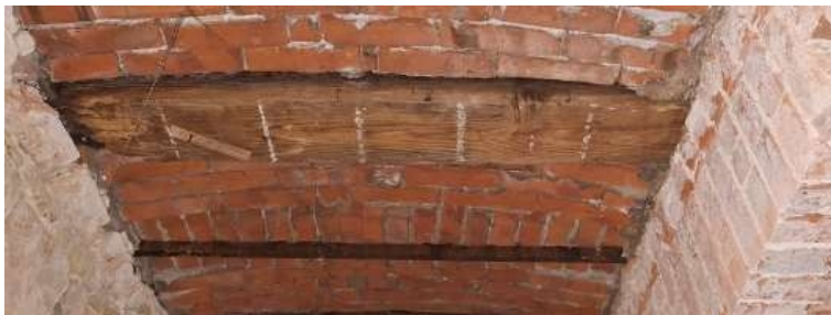
Foto Gewölbeunterseite. Die Holzbalken werden durch STB-Gewölbeabschnitte ersetzt.
