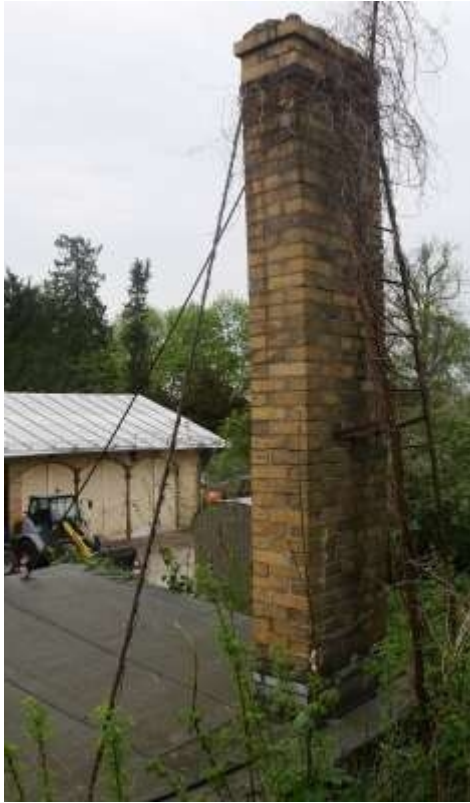
Schornstein Waschhaus, Zustand 2025
