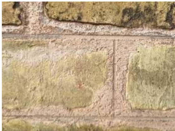
Fugenstrich Bestand Zustand 02/2026
