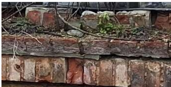
Mauerkrone / Rollschicht Zustand 02/2026
