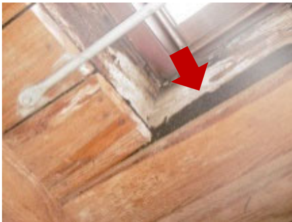
Abb. 19: Dachpappe, asbesthaltig
