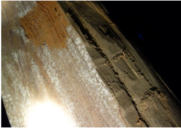
Abb. 17: Stütze mit kristallinen Ausbildungen Abb. 18: Balkenkopf
