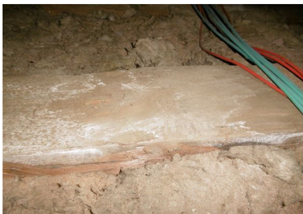
Abb.:15 Deckenbalken mit KMF
