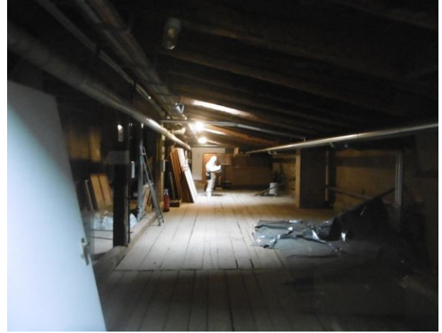
Abb. 8: Corp de Logis Dachraum
