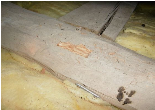
Abb. 31: Dämmung zwischen den Deckenbalken
