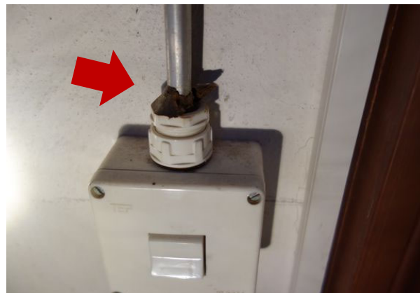
Abb. 22: Gurogit, asbestverdacht
