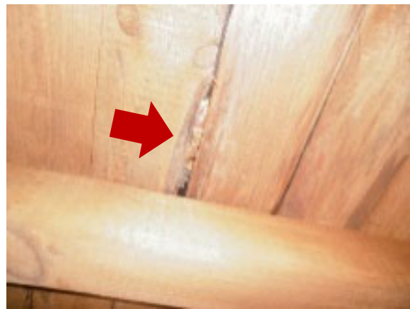
Abb. 20: Dachpappe, asbesthaltig
