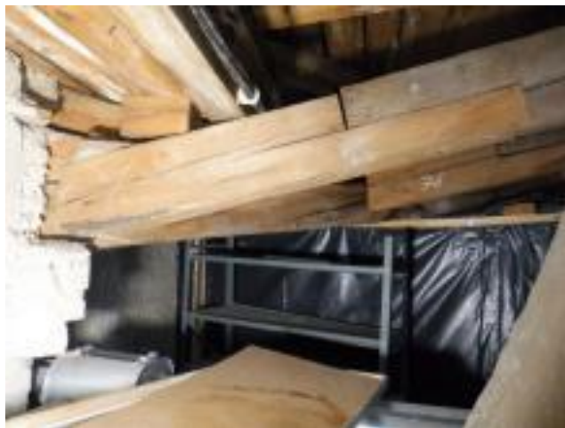
Heinrichbau Ostseite Kehle N/O mit Reparaturen
