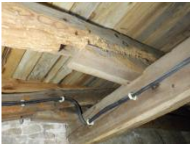
Heinrichbau Ostseite Anschluss zur Kehlbalkenlage an BTA 73 alter Fs durch Hbl inaktiv
