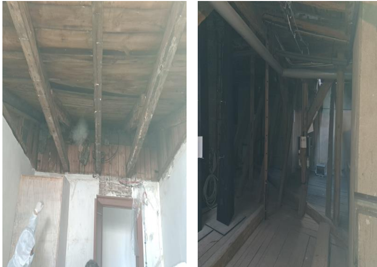
Foto 5+6: Holzschutzmittelbehandelte Konstruktionshölzer
