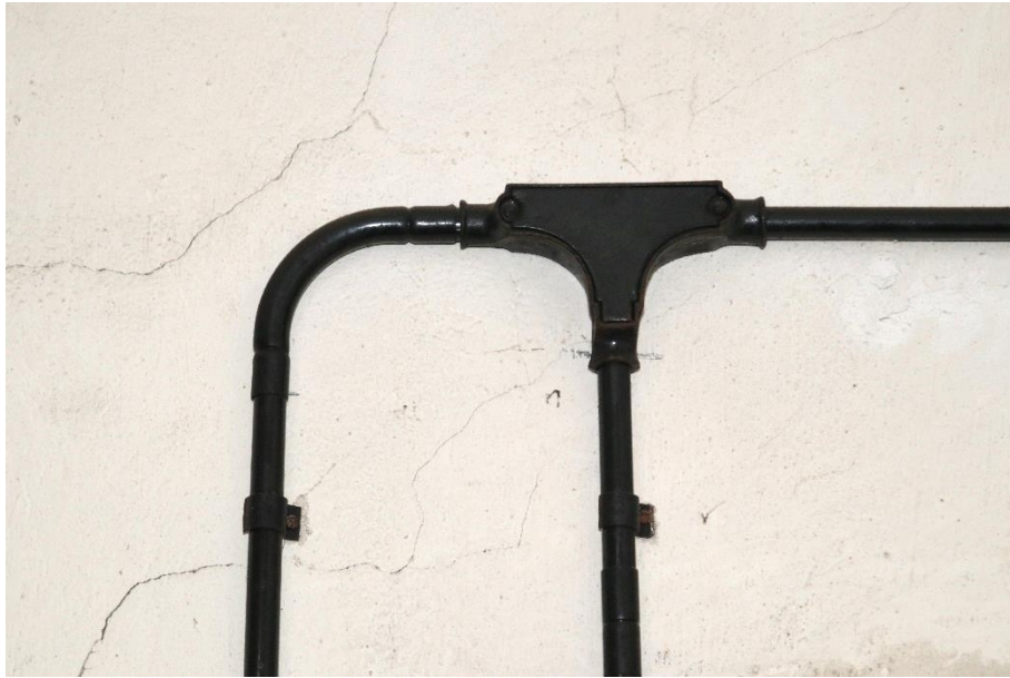
Abb.: 6 historische Kabelkanäle
