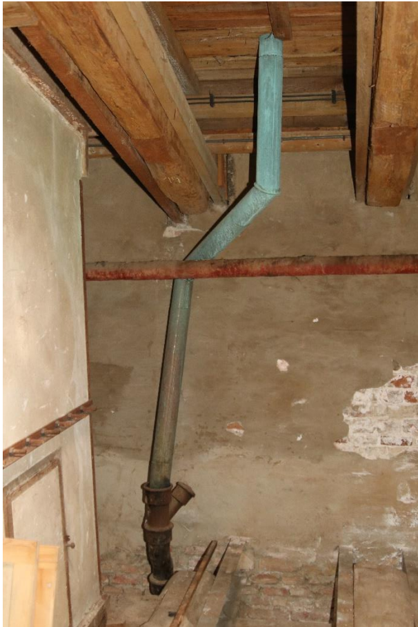
Abb.: 14 Dachentwässerung mit Fallrohr
