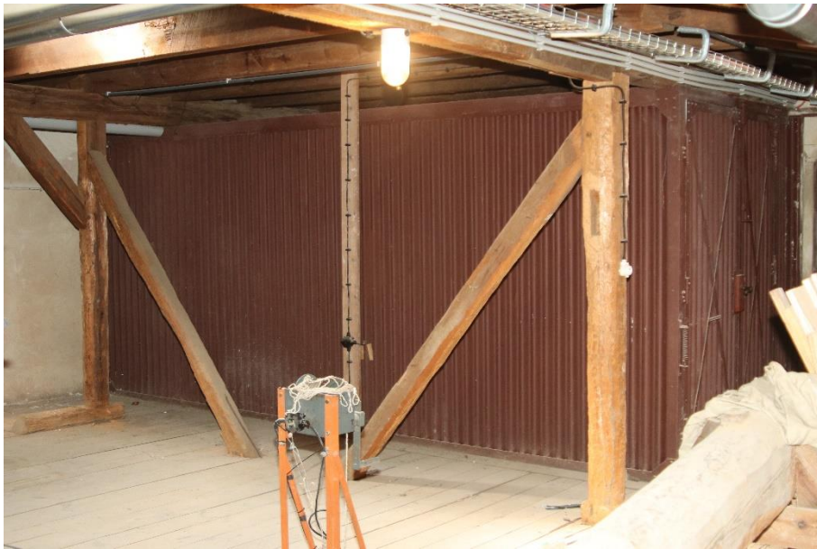
Abb.: 10 Stahlkonstruktion als Treppenüberbau mit Wellblech
