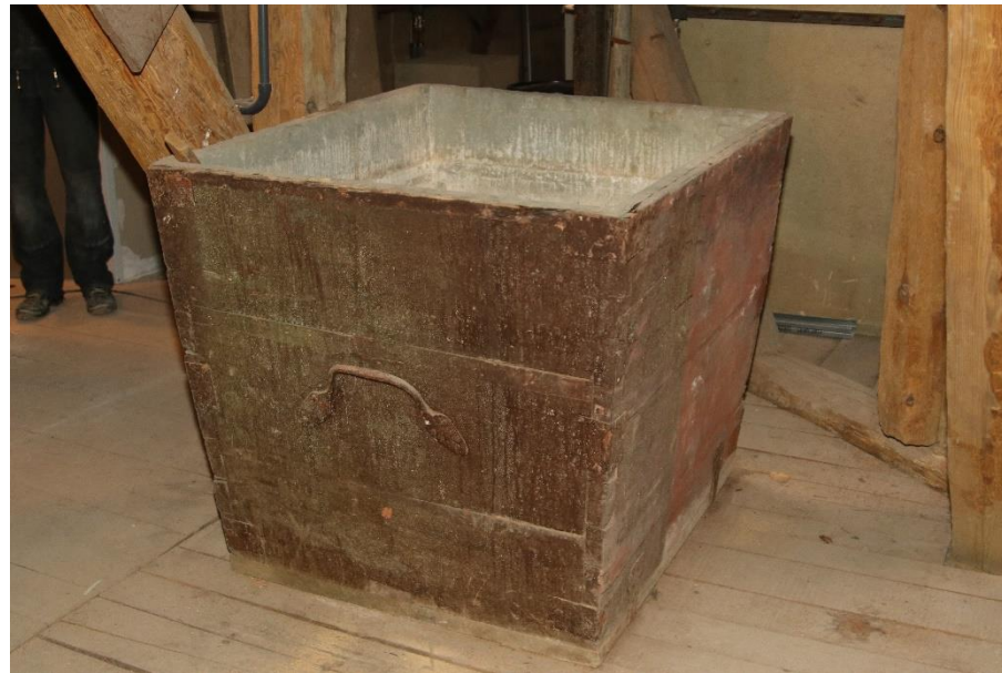
Abb.: 13 Löschwasserkasten
