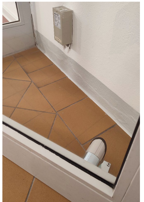
Abbildung 5, Feststeller als Magnet mit Netzteil
