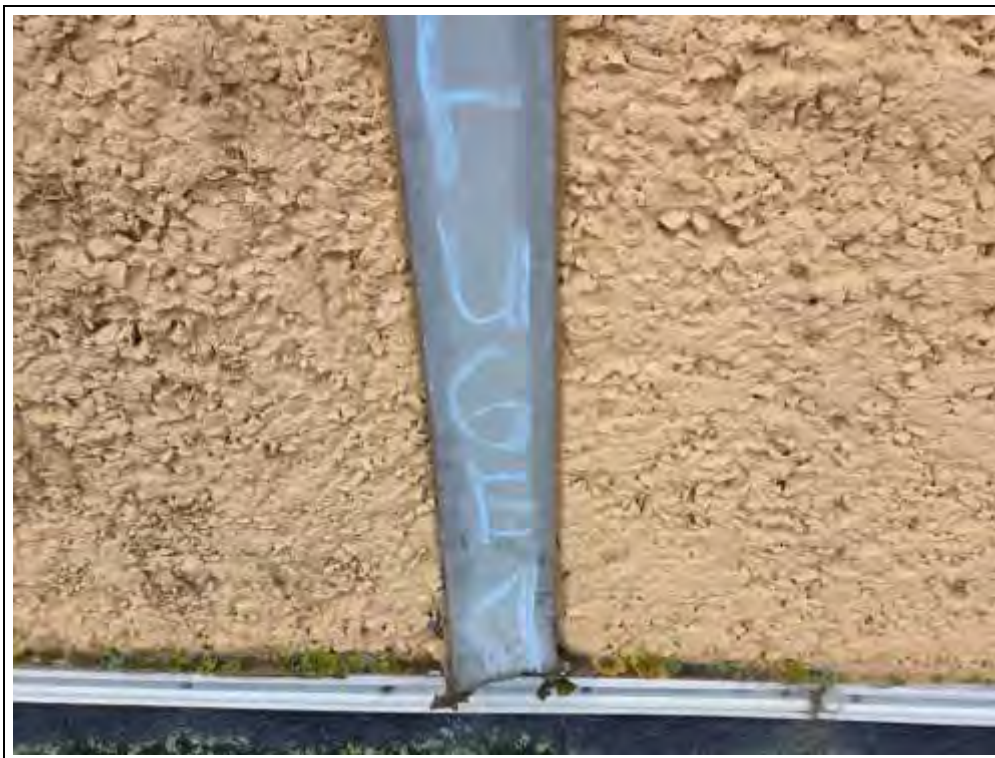
Foto 9: Die Fugen zwischen den Betonplatten wurden außen am gesamten Gebäude mit Gummimanschetten verschlossen.
