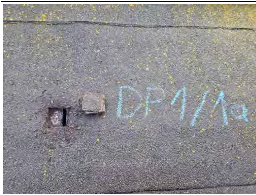
Foto 5: Ansicht des Probenahmepunktes in der äußeren Dachhaut. Aus der Dachhaut wurden hier die Proben DP 1 und DP 1a entnommen. Der Probenahmepunkt liegt genau über einer Fuge von zwei Dachplatten.
