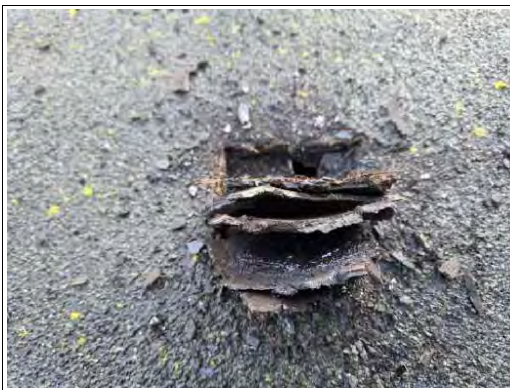
Foto 6: Die äußere Dachhaut besteht aus mehreren Lagen Dachpappe und ist insgesamt 2,5 cm stark.
