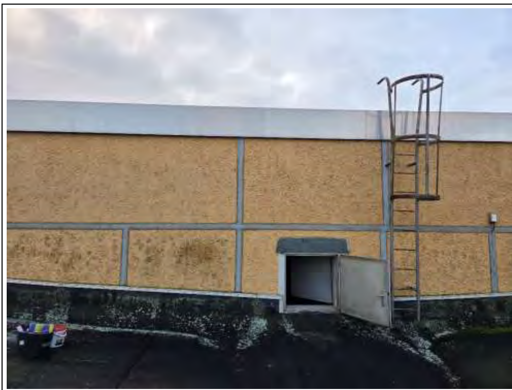
Foto 8: Der höher gesetzte Mittelteil auf dem Dach beinhaltet die Anlagen für den Fahrstuhl (Blickrichtung S).
