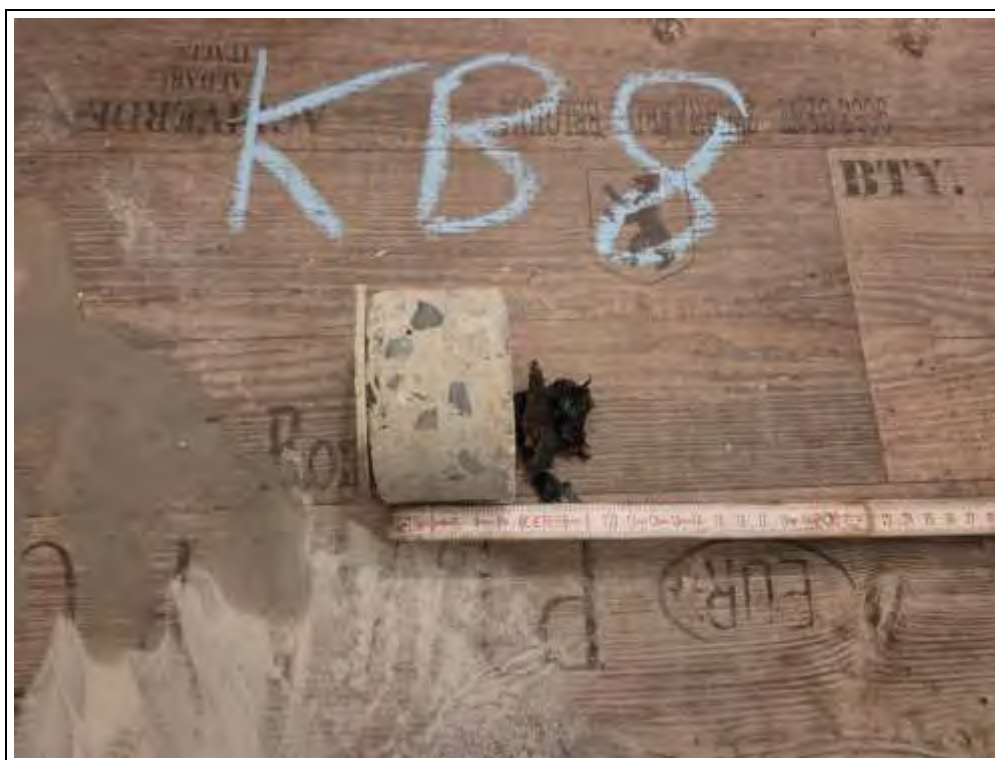
Foto 40: Bohrkern der Kernbohrung KB 8 mit Teilen der in den Bädern immer vorhandenen schwarzen Gummischüttung.
