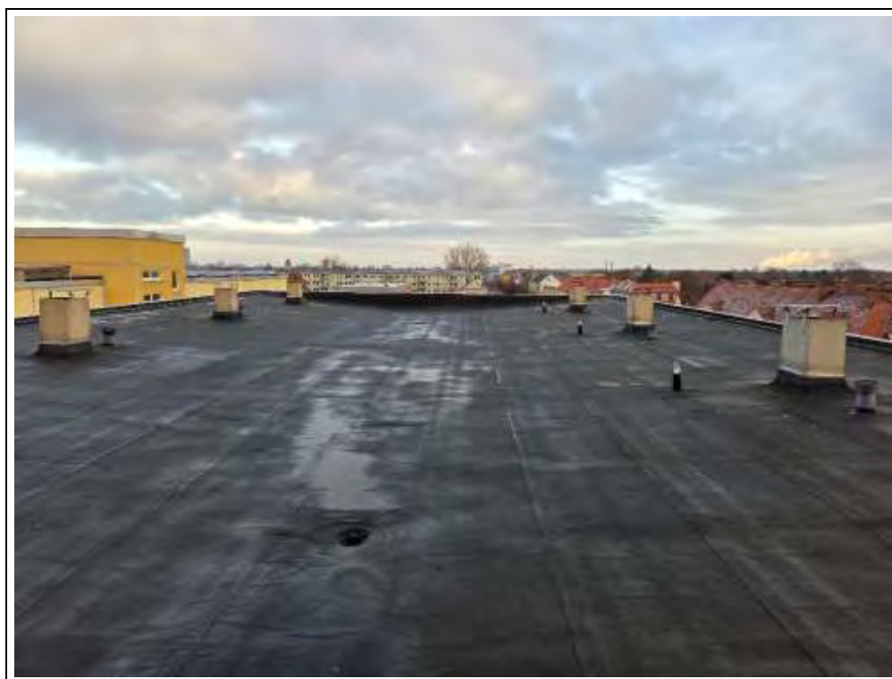
Foto 4: Nördlicher Dachbereich des Wohngebäudes (Blickrichtung NNE).
