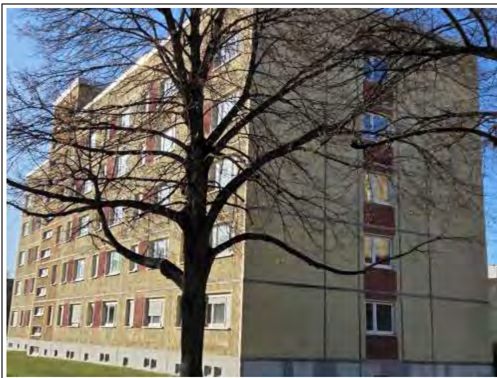
Foto 2: Ansicht der Ostseite und des Nordgiebels des Wohngebäudes Hufelandstraße 14 (Blickrichtung SSW).
