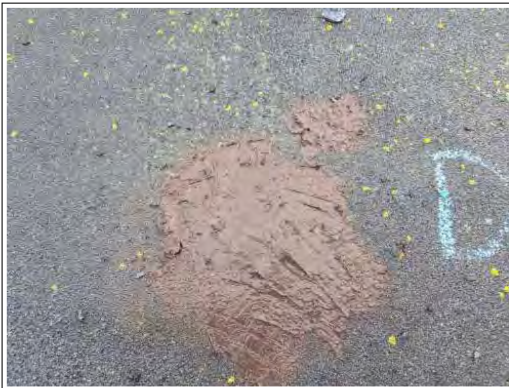
Foto 7: Nach der Probenahme wurde die Probenahmestelle wieder mit einem Dachdichtungsmittel verschlossen.
