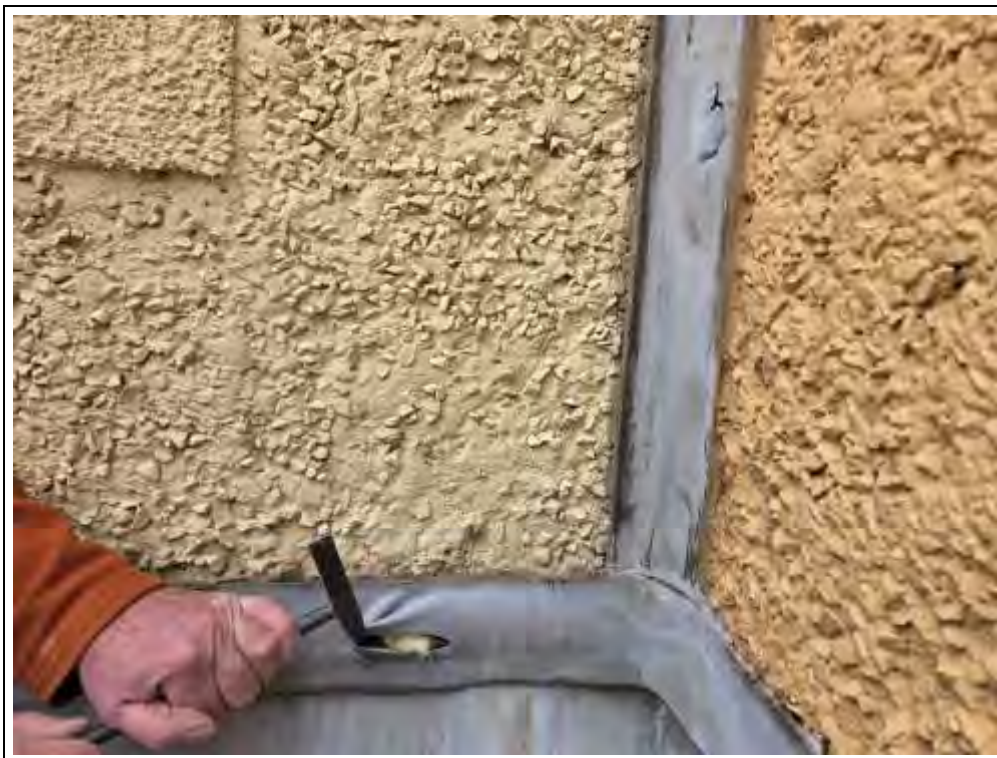
Foto 15: Horizontalfuge am Übergang Keller/Erdgeschoss mit KMF-Dichtung.
