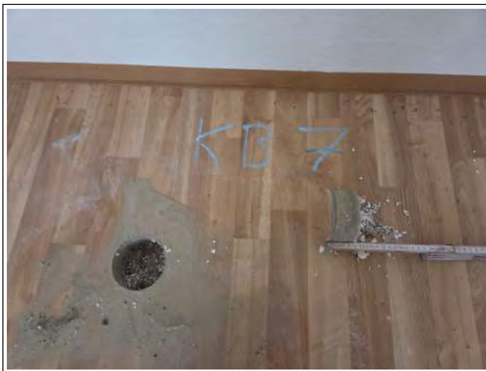
Foto 37: Ansatzpunkt und Bohrkern der Kernbohrung KB 7 im Wohnzimmer der Wohnung im EG. Unter der Klarsichtfolie ist auch hier eine dünne Schüttung aus Styroporkugeln vorhanden, die in die Mischprobe Dämm 2 einging.
