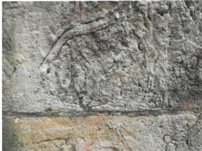
Abbildung 8 Zerklüftete, raue Oberfläche
