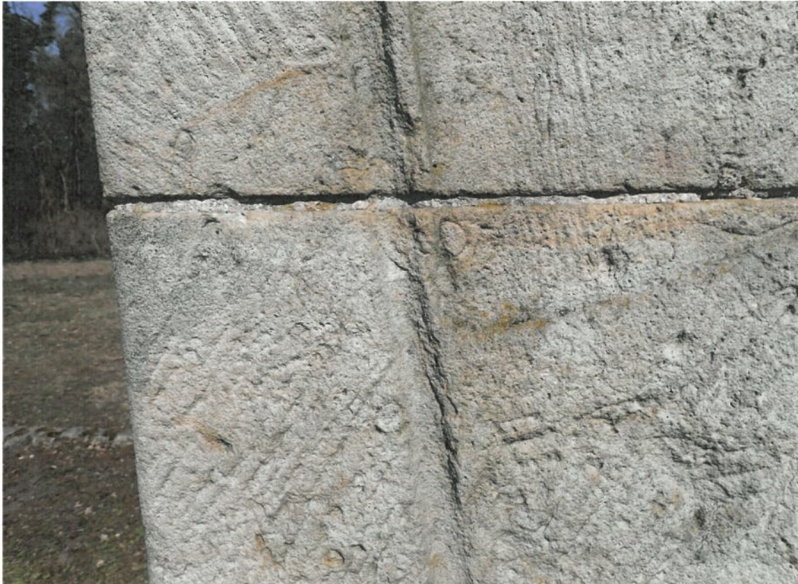
Abbildung 15 Defekte Fuge
