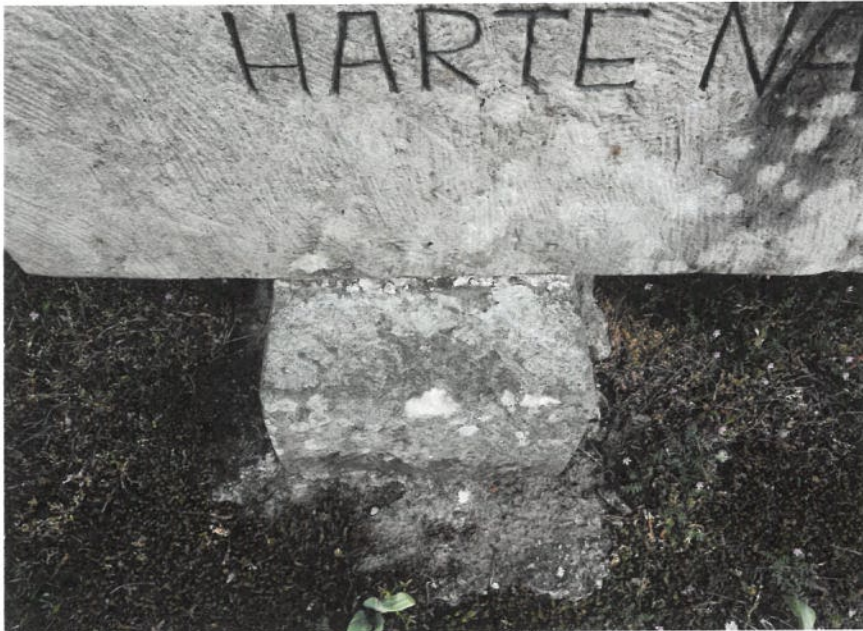
Abbildung 12 Freiliegendes Fundament
