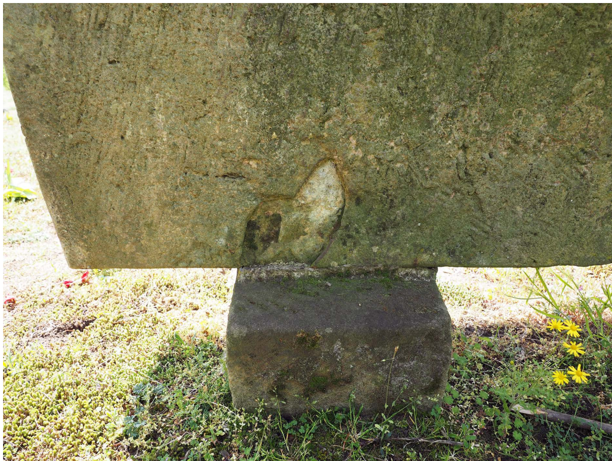
Abbildung 14 Fehlstelle mit entfestigtem Bereich
