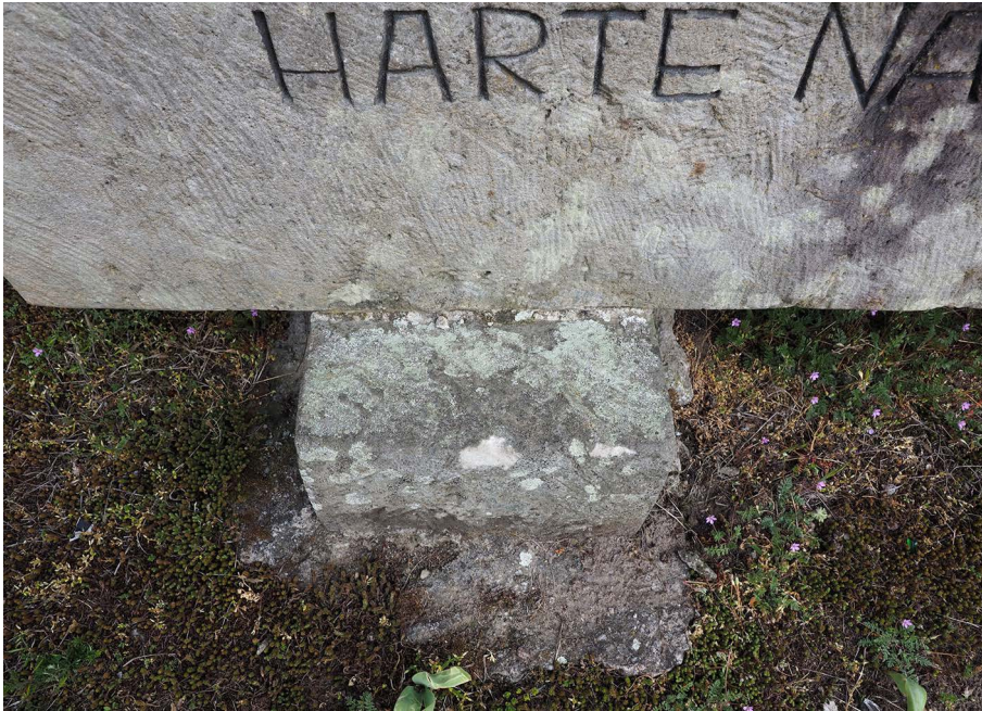
Abbildung 12 Freiliegendes Fundament
