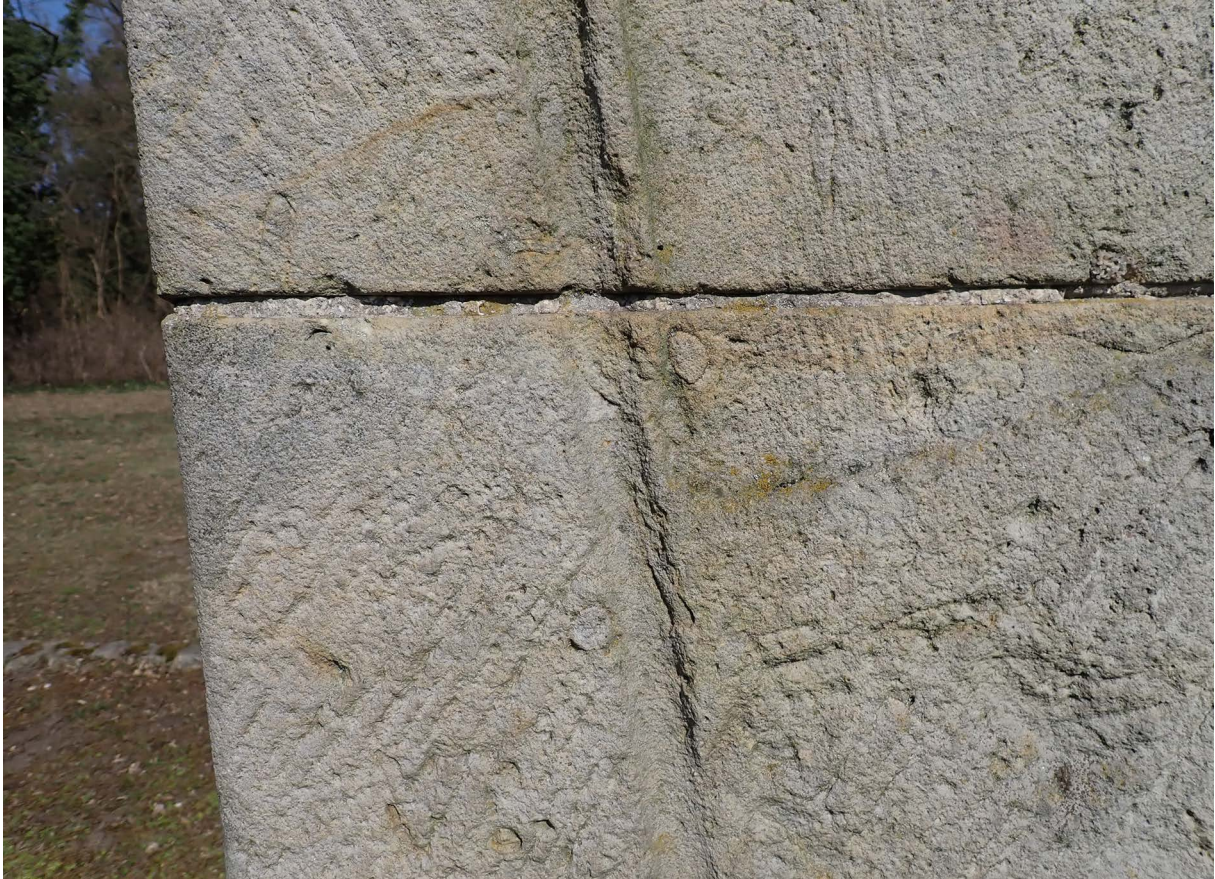
Abbildung 15 Defekte Fuge
