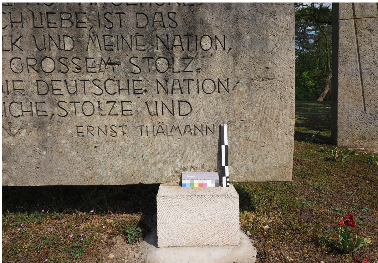
Abbildung 16 Vierung mit falscher Oberfläche
