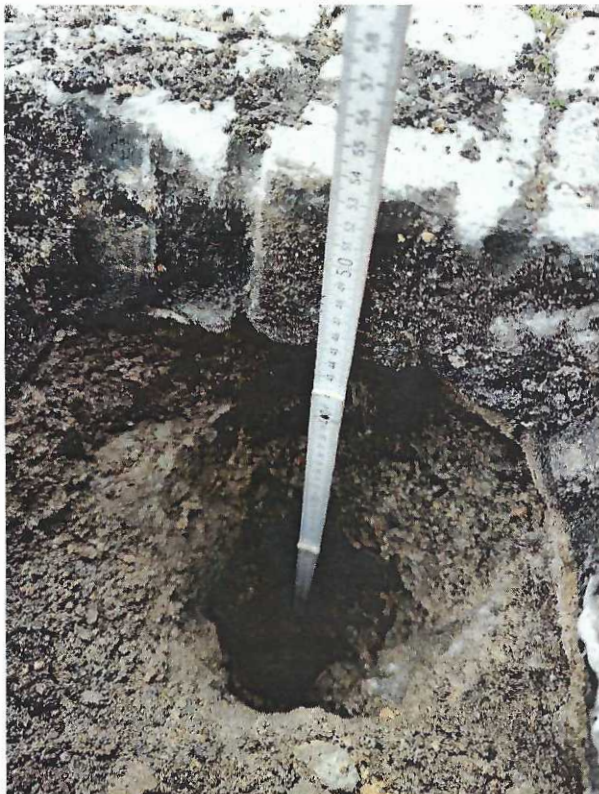
Foto: Forst/Lausitz, Muskauer Straße – A1 (Aufbruch)
