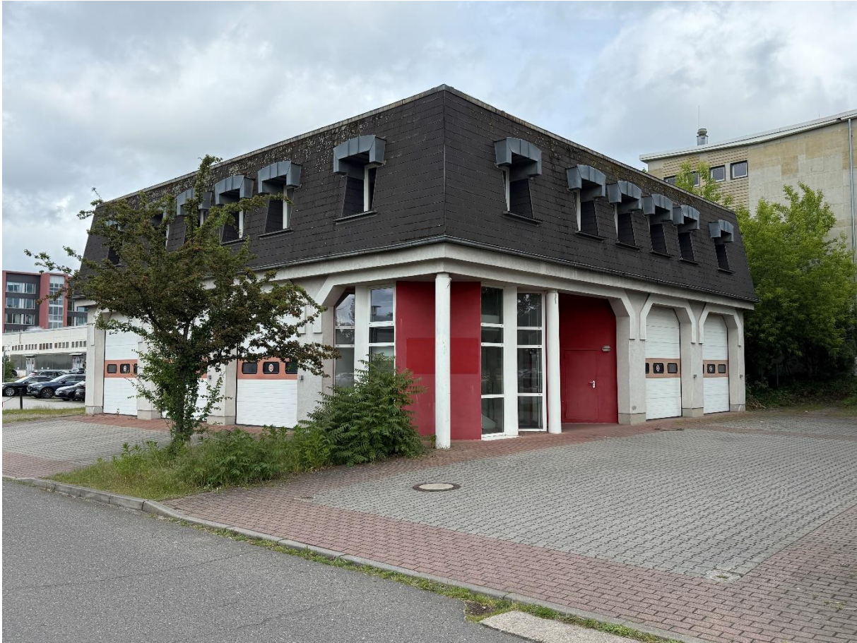
Abb.: Haus 77 Süd-West Ansicht
