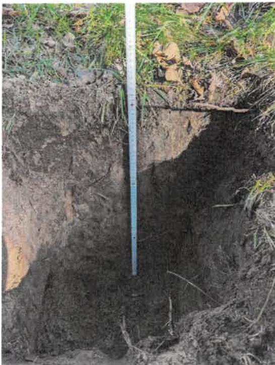
Abbildung 1: Schurf 1 bei Bohrung B1 auf der Dammkrone
