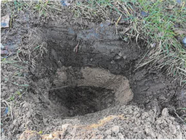
Abbildung 2: Schurf 2 bei Bohrung B2 auf der Dammkrone
