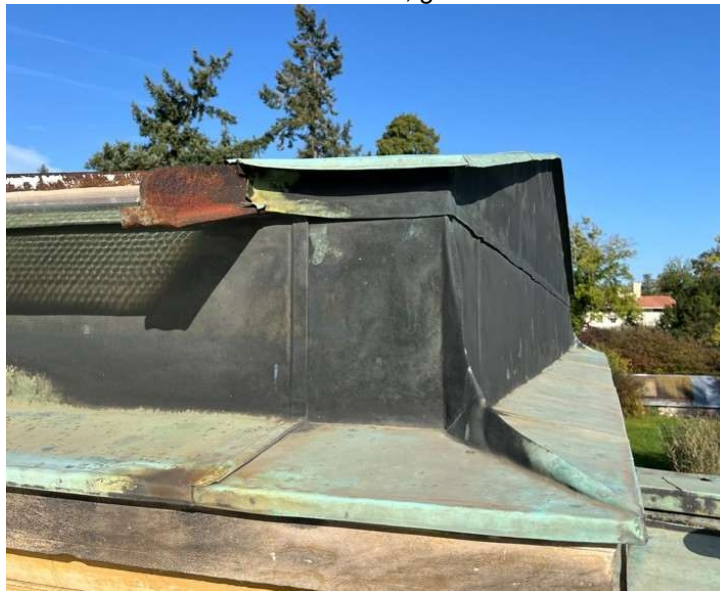
Bild: Bestand Giebel am Oberlicht, geschlossen
