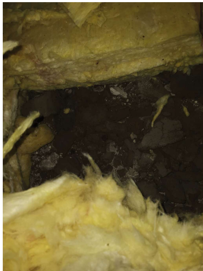
Schutt-Holz UK Saaldecke unter Mineralwolle
