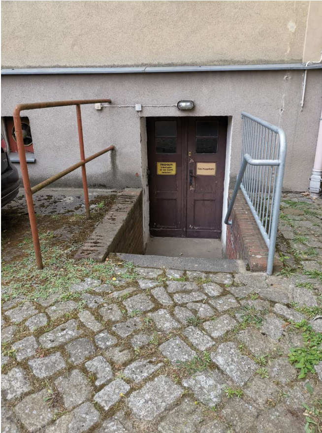
Kellerabgang zum Heizraum
