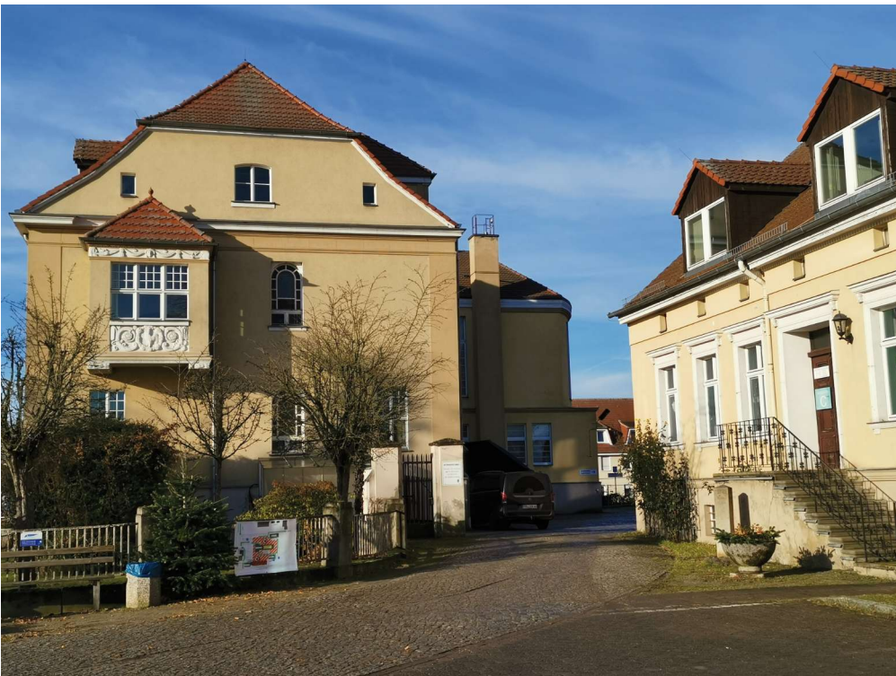
Zufahrtbereich Baustelleneinrichtungsfläche - Haus D im Vordergrund
