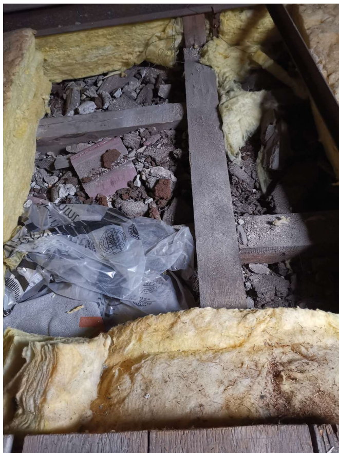
Schutt-Holz UK Saaldecke unter Mineralwolle
