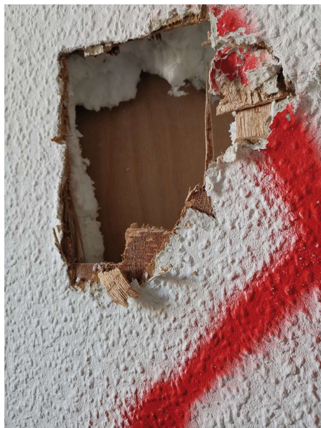
Holzständerwand mit Polystyrol
