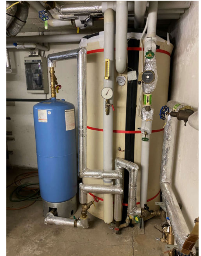
Abb. Nr. 34: Saarmunder Str. 14, KG, Warmwasserbereiter
