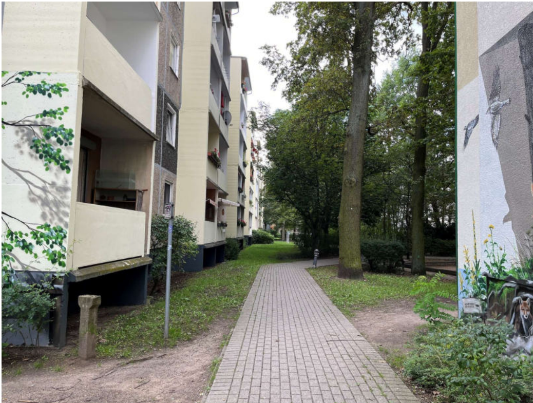
Abb. Nr. 6: Saarmunder Str. 6, Fassade West
