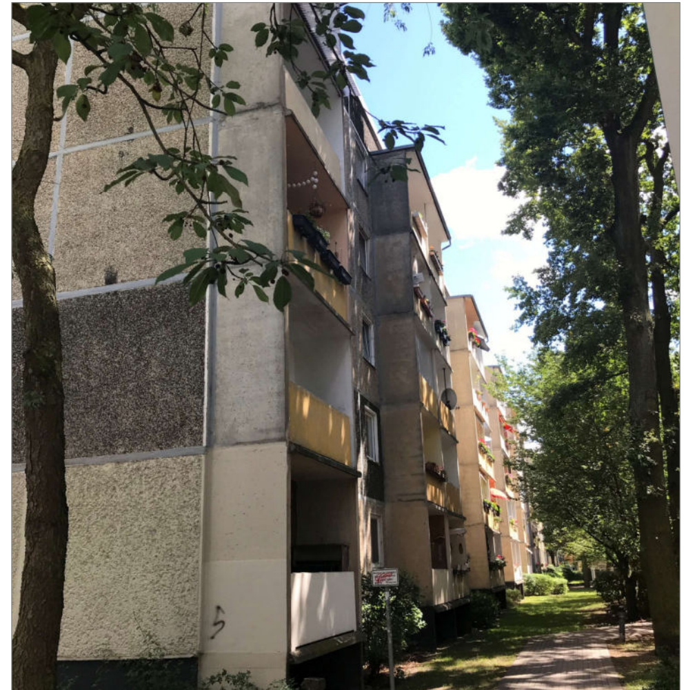
Abb. Nr. 7: Saarmunder Str. 6, Fassade West
