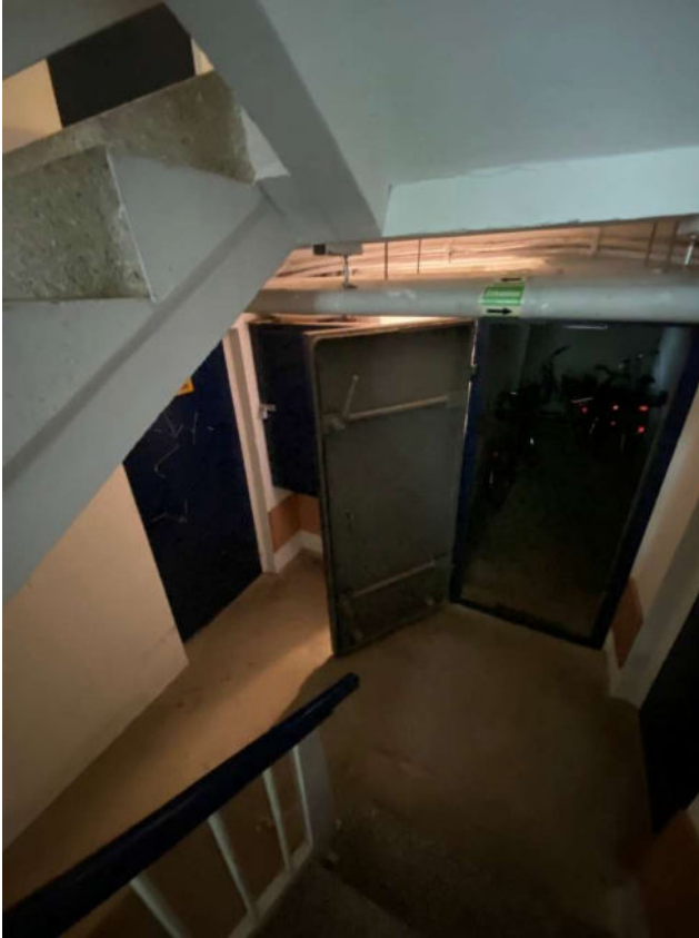
Abb. Nr. 35: Saarmunder Str. 14, Kellergeschoss, TK-BK-Anschluss
