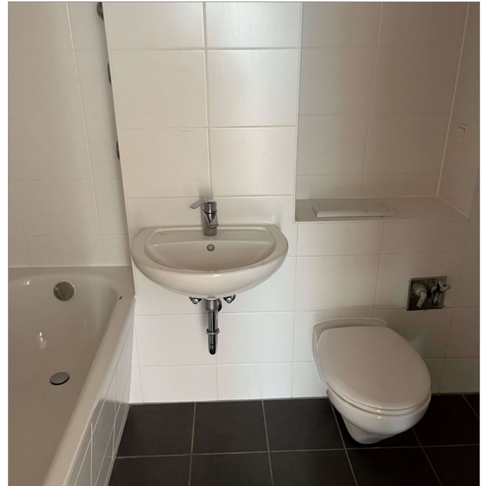
Abb. Nr. 27: Saarmunder Str. 18, 1-R-WE, Bad (Sanierung 1996)
