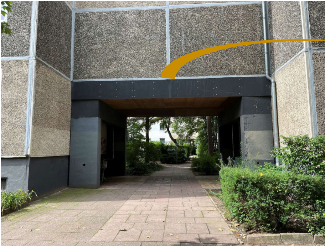
Abb. Nr. 4: Saarmunde Str. 14 u. 16; Verbinder; Durchgang / Zugang zum Innenhof
