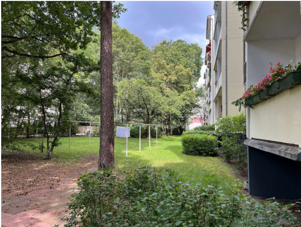
Abb. Nr. 12: Saarmunder Str. 14, Fassade West
