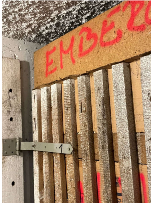
Abb. Nr. 39: Saarmunder Str. 6, KG, Mieterkeller, Kellerverschlag
