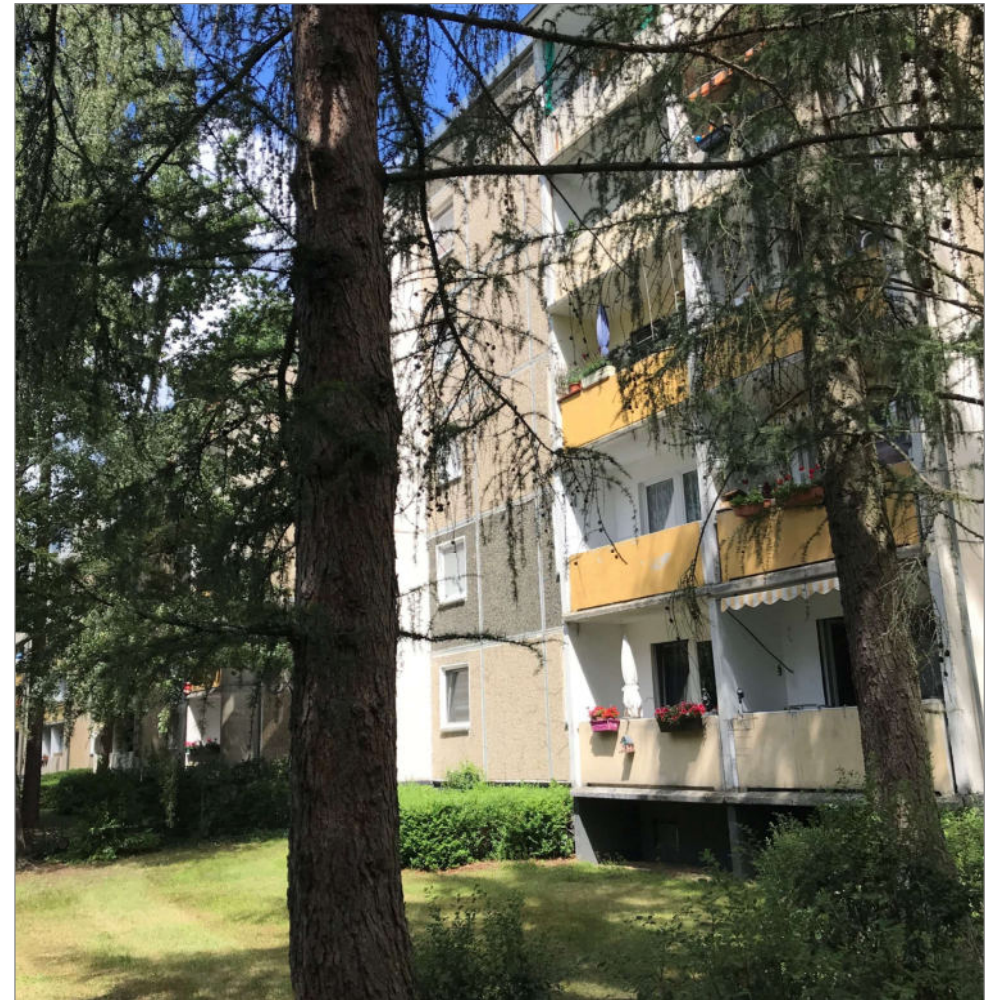
Abb. Nr. 15: Saarmunder Str. 16 und 18, Fassade West
