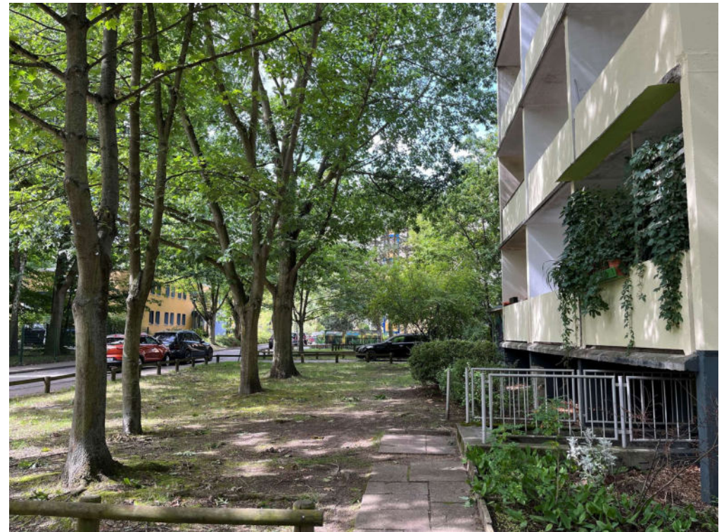
Abb. Nr. 11: Saarmunder Str. 18, Fassade Süd und Zugang zur HA-Station
