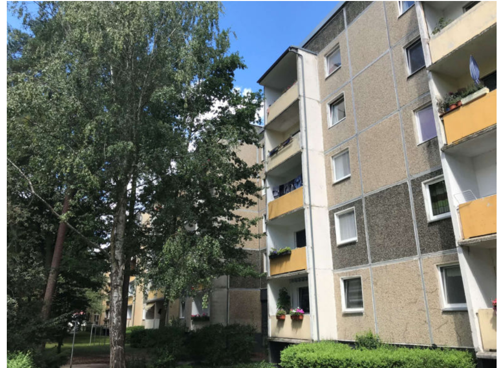
Abb. Nr. 13: Saarmunder Str. 16 und 18, Fassade West
