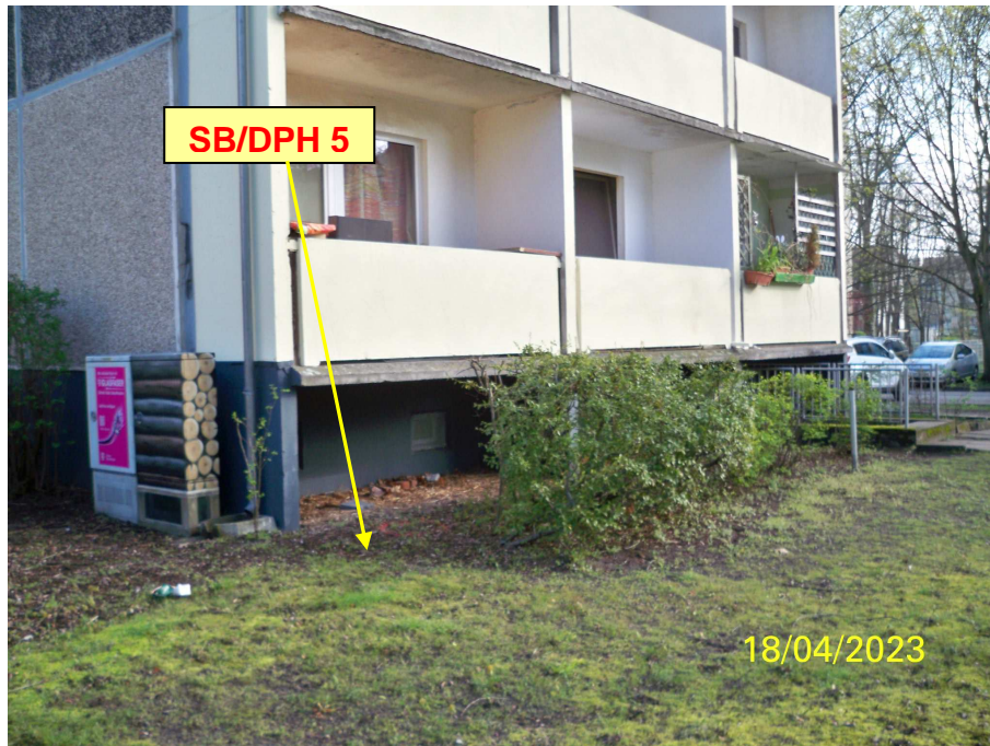
Teilübersicht Baufeld Blick von Südwesten auf die Balkonanlagen am Südgiebel des Kopfbaus am Gebäude Saarmunder Straße 18 mit Markierung der dort realisierten Prüfstelle SB/DPH 5
