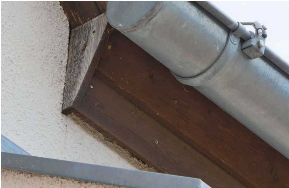
Gesimskasten bzw. Dachuntersicht an den vorhandenen Traufen:
