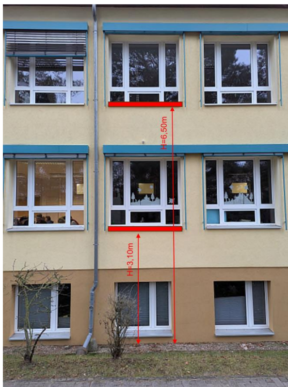
Abbildung 1 Foto 1: Souterrain, EG und OG mit stilisierter Gerüstbelags-Ebene bei Oberkante Brüstung vom EG und OG
